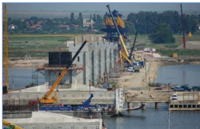
18. ábra: Vidin és Calafat között készülnek a híd pillérei
