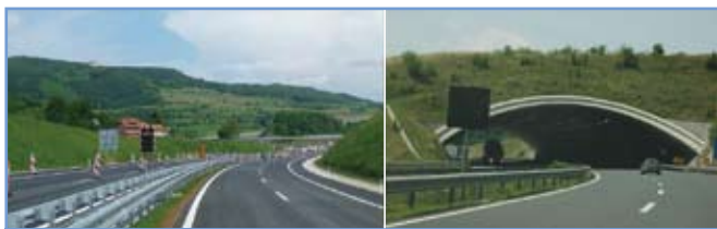
3. ábra: Az A2 autópálya új szakasza átadás előtt és egy alagútnak látszó műtárgy
