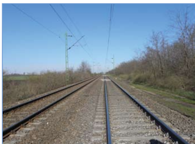
11. ábra: Vízszakos területek a Hegyeshalom–Budapest Kelenföld vasútvonal Lébény–Mosonszentmiklós és Kimle állomásközében Hegyeshalom irányában nézve, az 1621 és 1622 szelvények közül fotózva (saját fotó)
