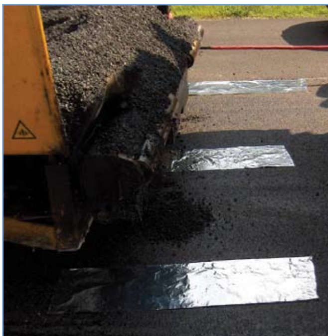
4. ábra: Az esetleges keresztmetszeti inhomogenitást ellenőrizni hivatott antipólusok a fektetést követően
