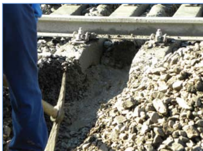
12. ábra: Feltárt vágat egy vízsák környezetében (saját fotó)
