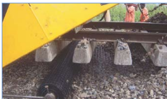
13. ábra: Georácsos ágyazaterősítés beépítés közben (Tensar International Limited, 2007)
