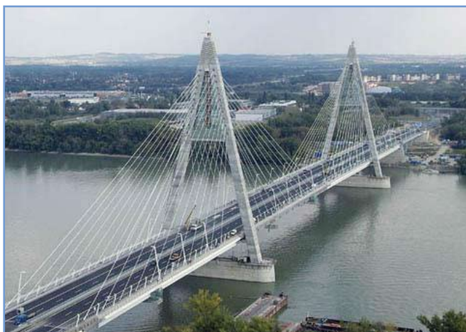
12. ábra: M0-s északi Duna-híd (Megyeri híd)
