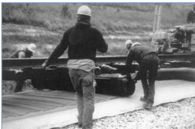
8. ábra: Georács erősítő réteg beépítése a vasúti zúzottkő ágyazat alá [13]
