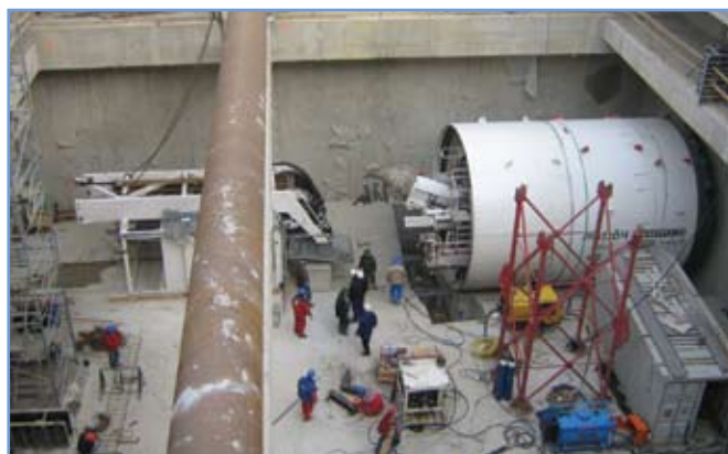
2. ábra: Az északi pajzs szerelése az Etele téri pajzsindító aknában. A pajzsokat a gyártóművi átvétel után szétszerelték, és részben közúton, részben vízen szállították Budapestre
