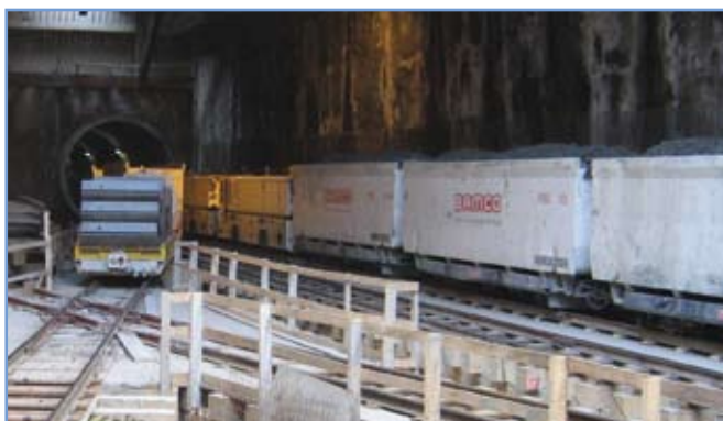
5. ábra: Kiszolgáló szerelvények találkozása a Tétényi út állomáson. A képen jól látható az állomáson kialakított vágánykép, amire a vonali összekötő alagutak építésének és a pajzskiszolgálásnak az összehangolása miatt van szükség.
