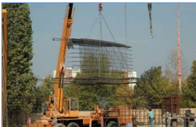
1. ábra: Bordás résfal betonacél-erősítésének helyszíni szerelése
