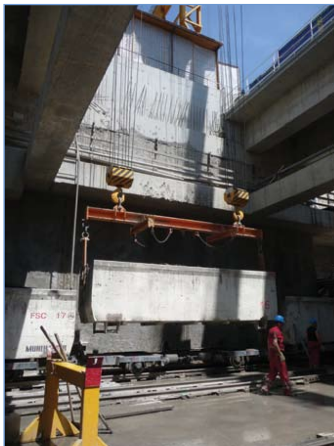
7. ábra: A földszállító csillék kiemelését és ürítését a felszínen telepített portáldarukkal végzik
