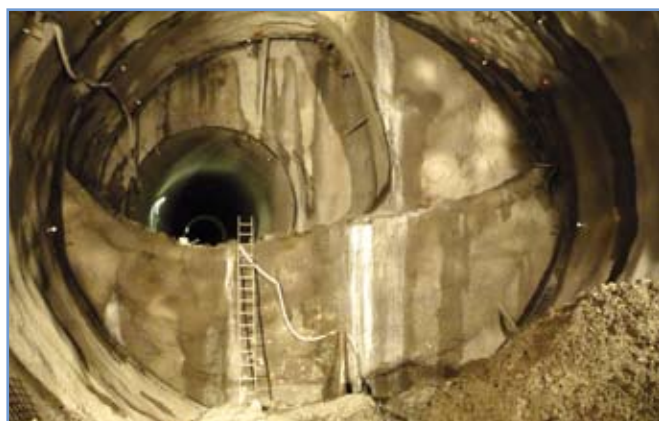
5. ábra: Vágánykapcsolati műtárgy, jobb trombita építése. Az ábra bal oldalán a pajzsral épült, 5,20 m belső átmérőjű tűbbinges alagút látható
