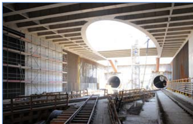
4. ábra: Látszóbeton minőségű belésfalak építése és az elkészült ellipszis peremgerenda
