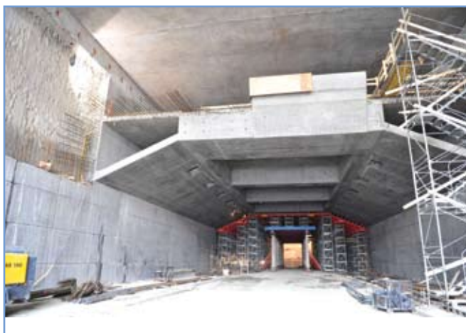
6. ábra: A ferde kitámasztású földémszakasz kiszaluzva
