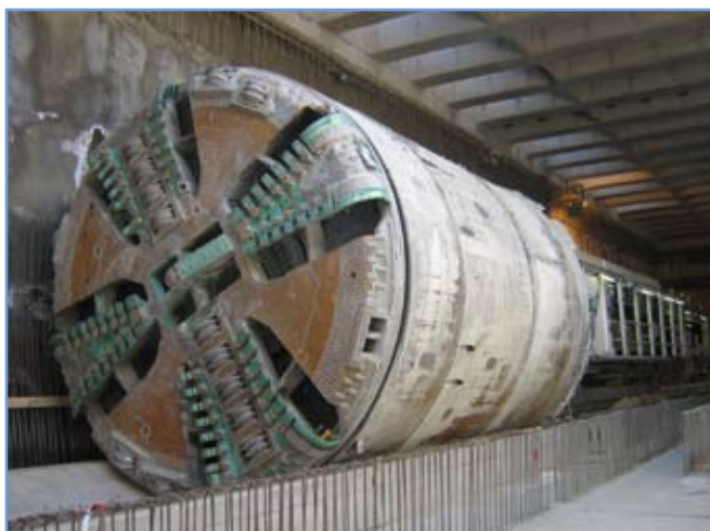
4. ábra: A déli pajzs a Tétényi út állomáson a betörés után
