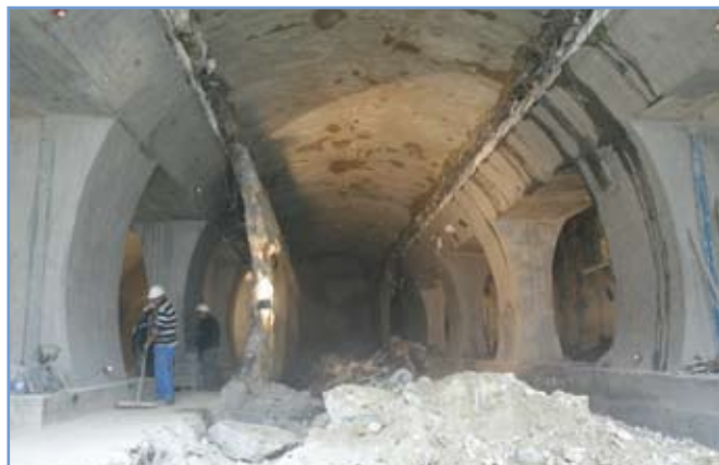
2. ábra: A bányászott állomásrész elosztó alagútjának ideiglenes szerkezete elkészült, a pillértáró primer biztosítása elbontható
