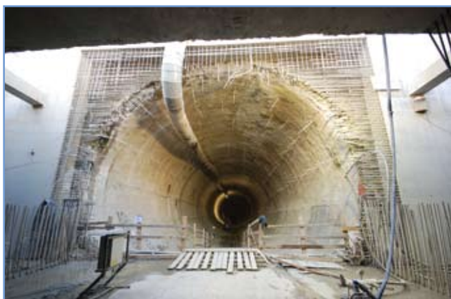
7. ábra: Bányászott alagút elkészült külső héjja
