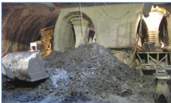
2. ábra: Szent Gellért tér állomás, a háromcsöves szakasz pilléralagútjai a kész pillérekkel
