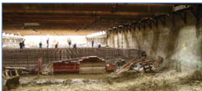
5. ábra: Az állomás alaplemezének vasszerelése
