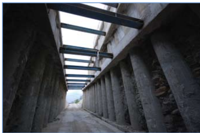
8. ábra: A kitámasztott cölöpfalak között épített ideiglenes lejárórámpa
