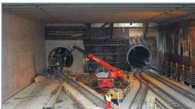
5. ábra: Vízzáró, látszóbeton minőségű bélésfalak építése az alagútépítést kiszolgáló vasúti forgalom váltakozó terelése mellett
