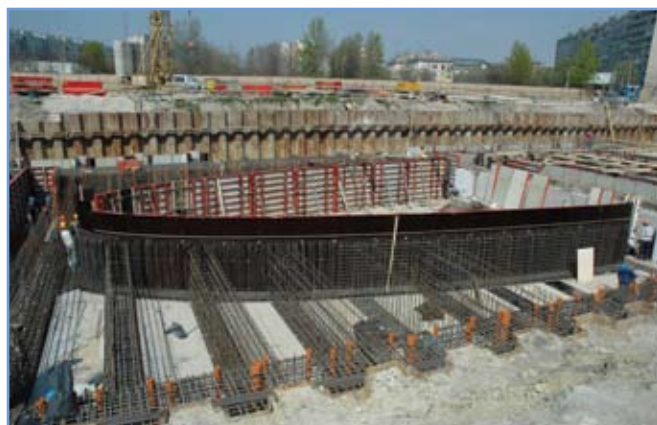
3. ábra: Földembordák és ellipszis peremgerenda építése
