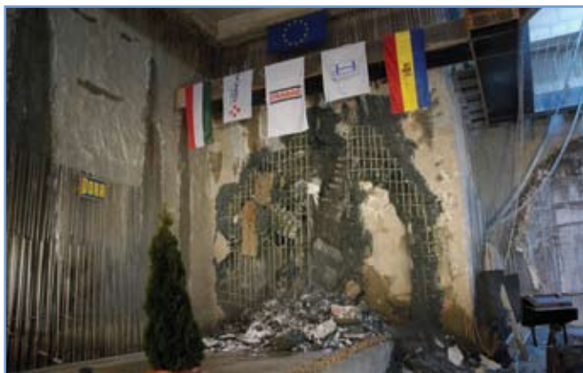
2. ábra: Az alagútépítő pajzs áttöri a GFK-erősítésű résfalat
