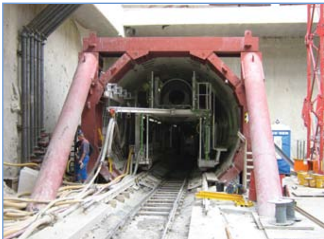
6. ábra: Nyomókeret és segédtübingek az állomásból kiinduláshoz
