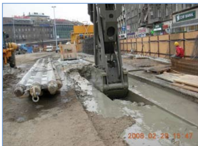
2. ábra: Résfal építése az állomási műtárgyban gyűrűs, toldható szakaszoló elemekkel
