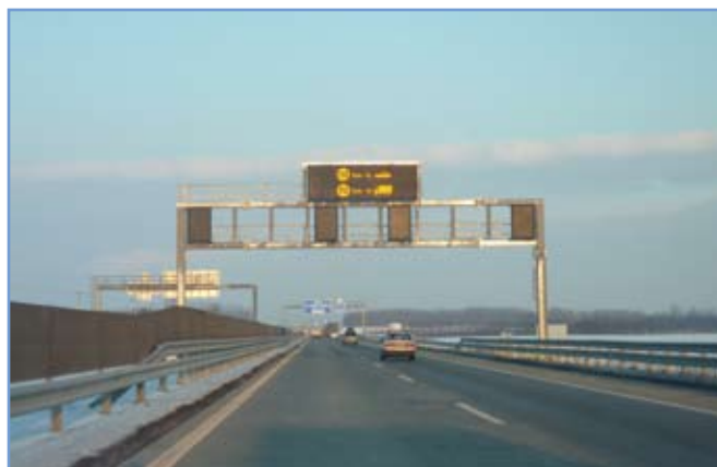
3. ábra: Kétszintes VJT-portál az M0 keleti szektor M5 és 4-es út csomópontja között
