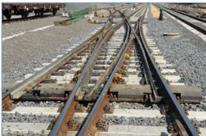
2. ábra: Az átszelési kitérők két fő típusa: a, Belső csúcscsínés átszelési kitérő. (A MÁV vonalain használatos 60-XIV-R=200-1:9 kitérő.) b, Külső csúcscsínés átszelési kitérő. (Az Ausztriában szabványosított 60-R=500-1:9 rendszerű kitérő.)
