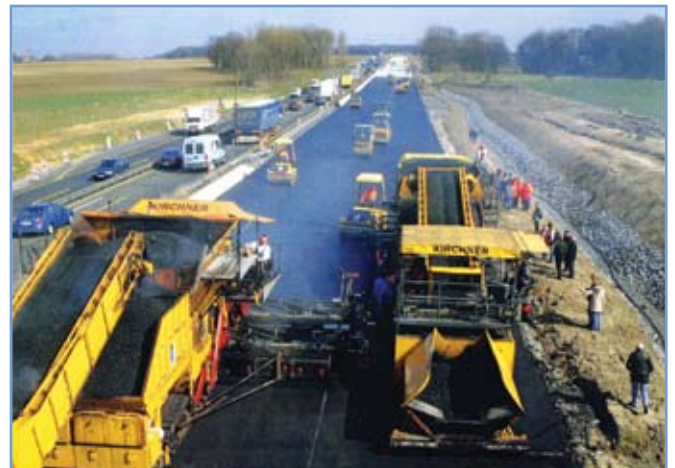
3. ábra: Kompaktaszfalt beépítése kettős finiserrel
