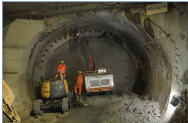
4. ábra: Fagyasztólándzsák elhelyezése a Duna alatti északi peronalagút 2. szakaszához, 2009. február
