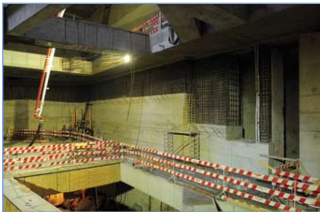
3. ábra: Megkezdődött a földkiemelés utolsó szakasza, 2008. szeptember
