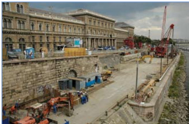
1. ábra: Réselés hidrofrézéssel az alsó rakparton, 2007. június
