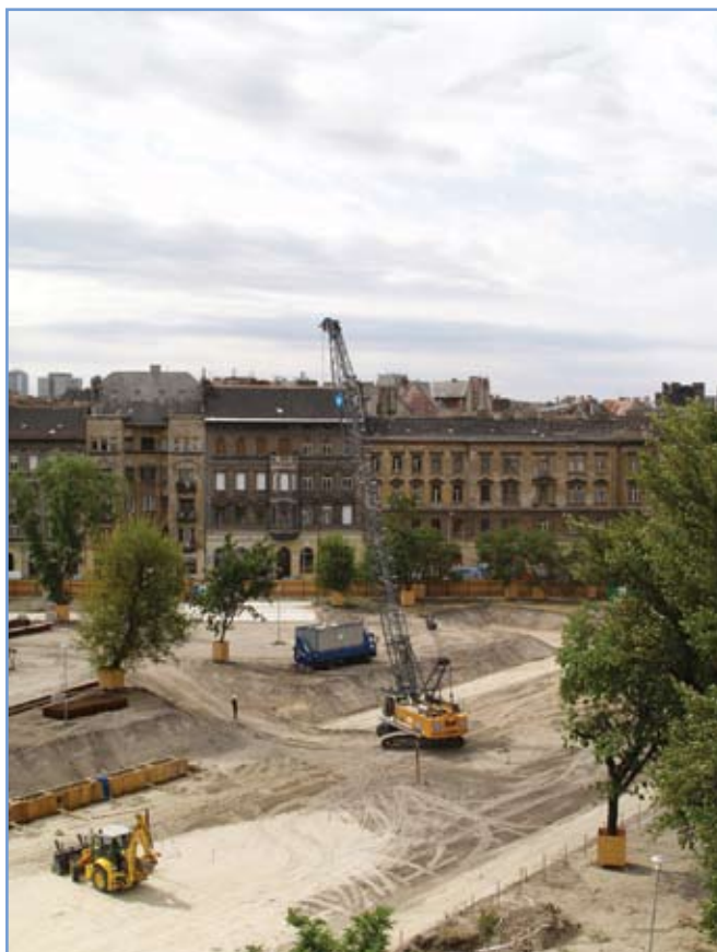
2. ábra: A lavírsíkon épül a résvezető gerenda
