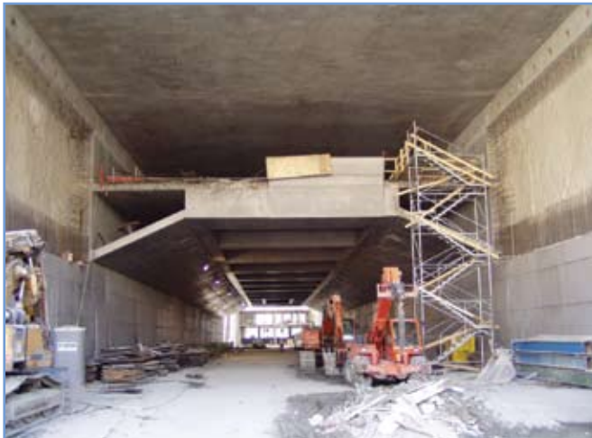
9. ábra: A Kelenföld állomáson a vasúti vágányok híd szerkezei alatt magas minőségű látszóbeton felülettel készül a peron feletti, épített szellőzőkkel kombinált aluljárófödém
