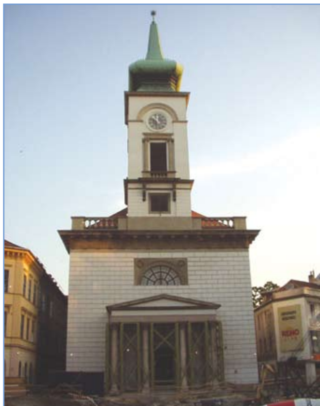
3. ábra: A Kálvin téri templom portikuszának megtámasztása
