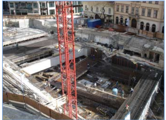
1. ábra: A gerendás földem építése
