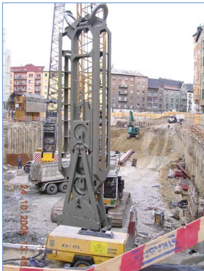
1. ábra: A munkagödör képe a réselés megkezdésekor
