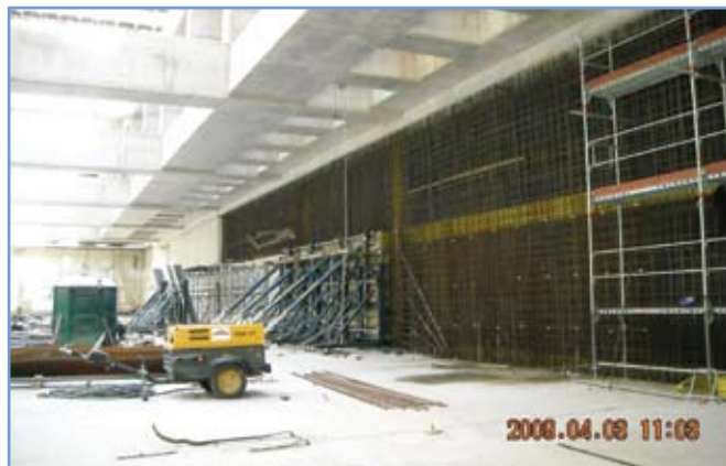
6. ábra: Bélésfal építése az alaplemez és az alsó kitámasztó rendszer között
