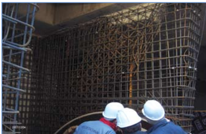
4. ábra: Különös gonddal történt a vasalások ellenőrzése
