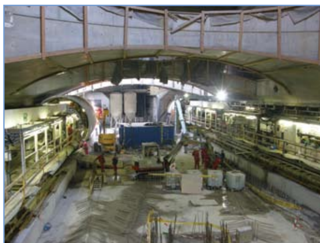
4. ábra: Beérkezett mindkét alagútépítő géplánc
