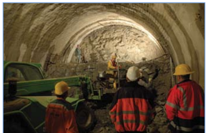
4. ábra: A vonali szellőzőalagút építése bányászati módszerrel
