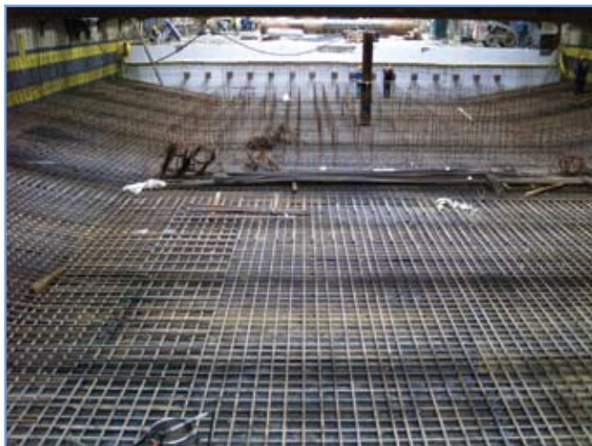
5. ábra: Az alaplemez középső szakaszának vasszerelése
