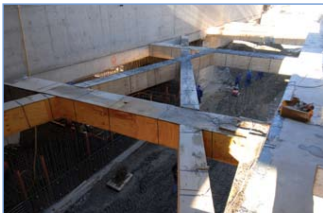
2. ábra: Látszóbeton gerendarács a lejtaknában, építés alatti felületvédelemmel, 2008. január
