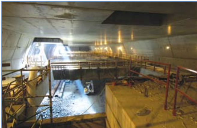
3. ábra: Földkitermelés az ideiglenes kitámasztás szintjéig
