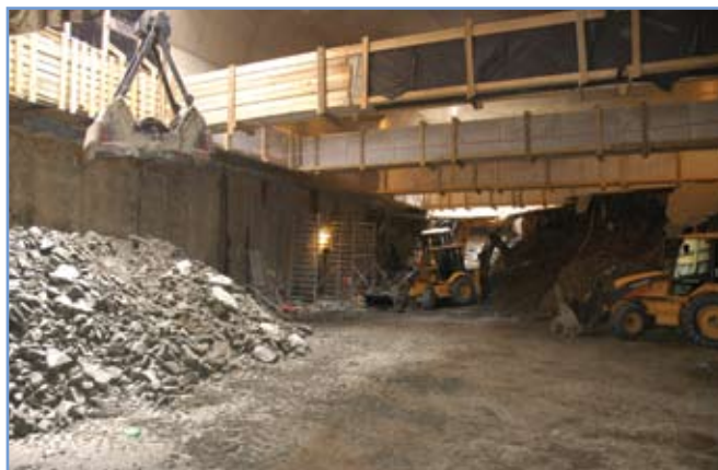
2. ábra: Az elkészült zárófödém és kitámasztógerendák alatt folyik a munkagödör mélyítése
