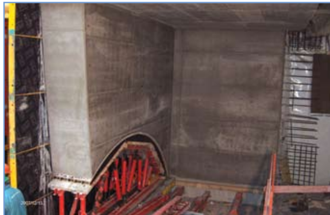
5. ábra: Jól kivitelezett látszóbeton
