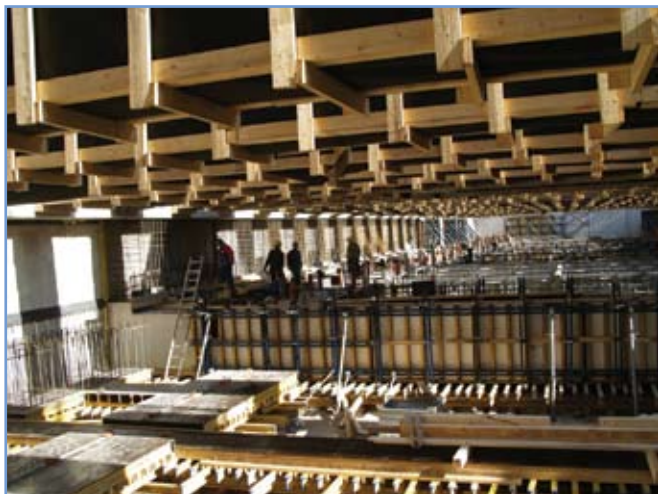
3. ábra: A P+3 szint (felső) kitémasztó rendszer építése
