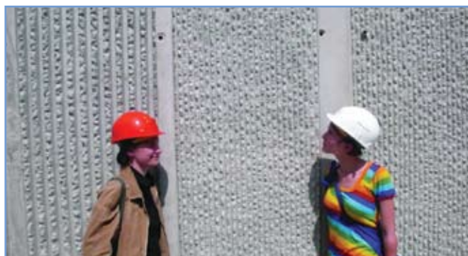
3. ábra: A látszóbeton felületek strukturált megjelenéséről többféle zsalumatríca próbafelületi használata alapján döntöttünk
