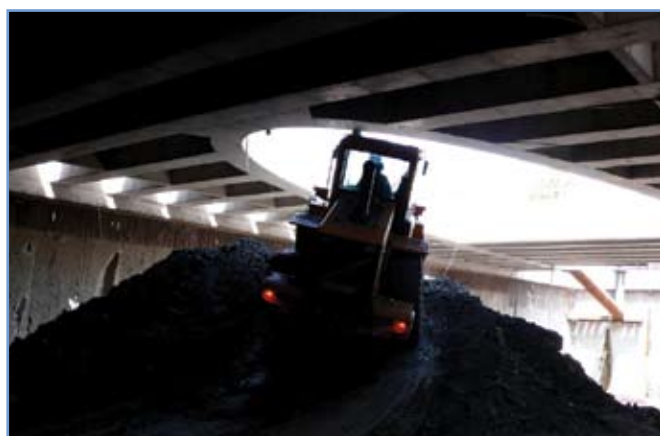
4. ábra: Földkiemelés a nagyfeszítávú alulbordás földem alatt (Tétényi út)
