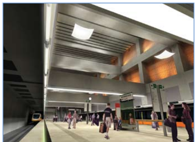
8. ábra: A Népszínház utcai állomásban a kitámasztó gerendák két szinten, váltakozó pozícióba kerültek
