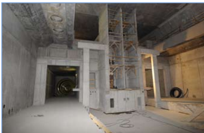
5. ábra: A pajzs elhaladása után épülhet az üzemi tér
