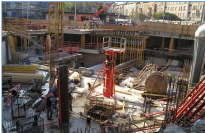
3. ábra: Az állomás a mélyépítési szerkezetek építésének befejezése után
