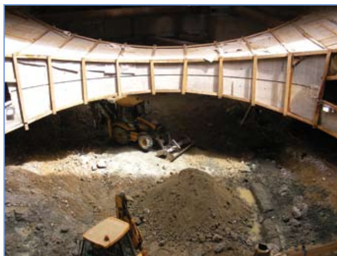
5. ábra: A 'kutyacsont' építés közben, felületvédő szerkezetekkel ellátva
