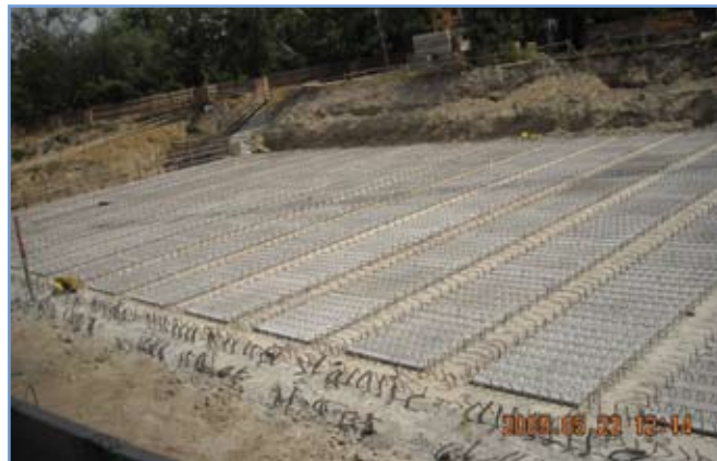
7. ábra: A zárófödém teherviselésben is résztvevő kéregpanelei
