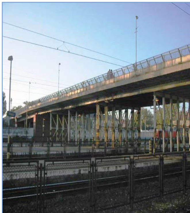
7. ábra: A győri Baross híd a felújítás előtt
