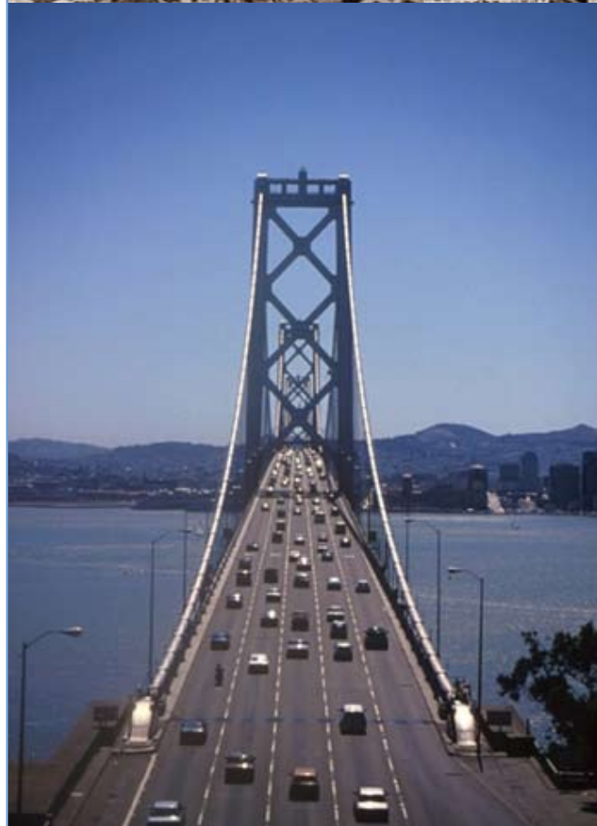
1a és 1b. ábra: Az Oakland-Bay-híd építés közben és ma (1933-ban épült duzzasztott agyagkavics adalékanyagossal könnyűbetonból) [2]
