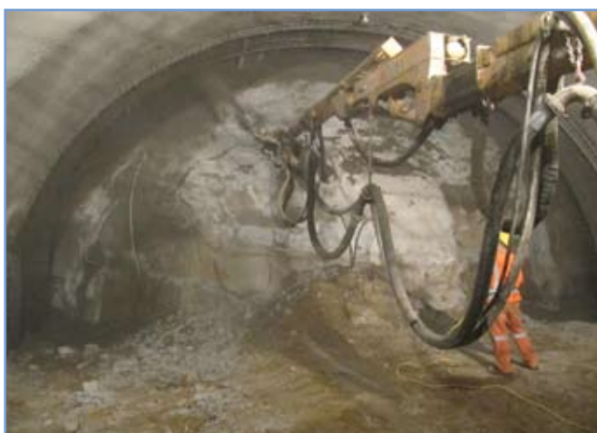
10. ábra: Talajszilárdítás a mélyben
