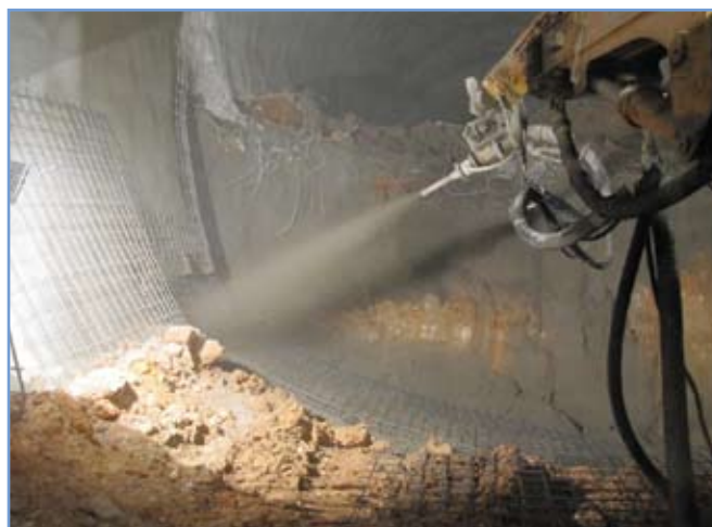
4. ábra: Szórófej és az ellenboltozat betonozása
