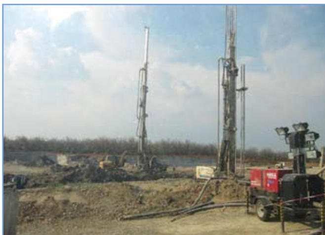
9. ábra: Jet Grouting készítése a felszínről
