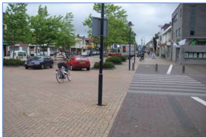
3. ábra: Noordkade/Zuidkade csomópont-becsatlakozás terelőszlopokkal, Drachten
