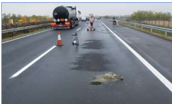
2. ábra: Tömörítetlen kopóréteg az M3-as autópálya 85+500 és 86+050 km-szelvényei között
