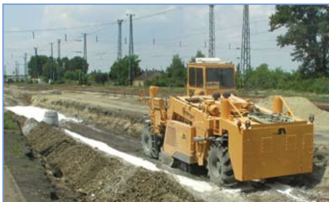
5. ábra: Talajstabilizáció folyamata, talaj és a kötőanyag bekeverése
