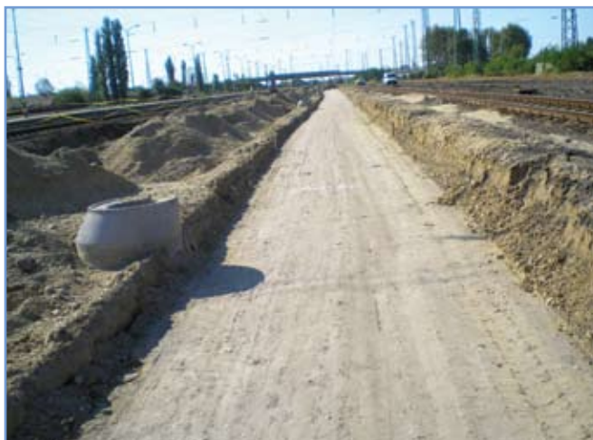
6. ábra: Stabilizált alépítmény
