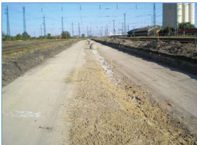
7. ábra: Kész stabilizált alépitmény
