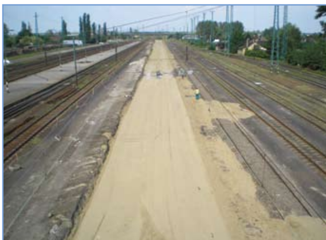
8. ábra: Kész stabilizált alépitmény szivárgóval
