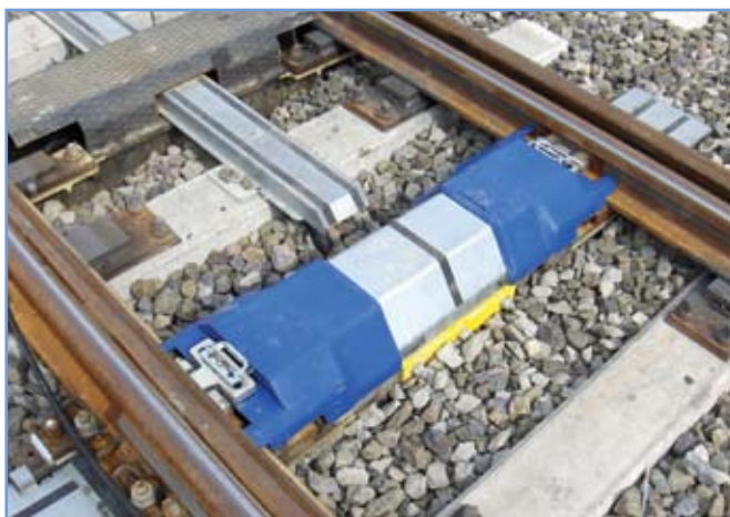
3. ábra: Kitérő Spherolock-zárszerkezettel és Hydrolink-közlőművel
