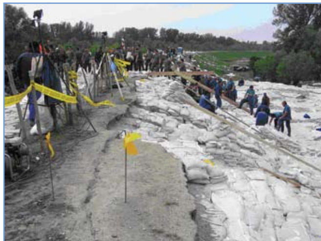
7. ábra: Másodlagos tömbös elválások a töltéskoronán (0+500 tkm)
