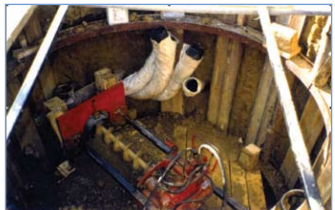
6. ábra: A vízvezető rendszer építése szakaszosan toldott acélcsövekkel és fúrással, majd a 200 mm-es acélcsöbe befűzött, 160 mm átmérőjű bordázott dréncsővel kialakított, 16–24 m hosszú vízvezető csövekkel
