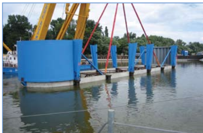
2. ábra: Kéregelem elhelyezése
