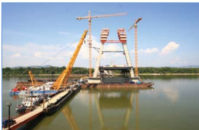
4. ábra: Épül a pylon
