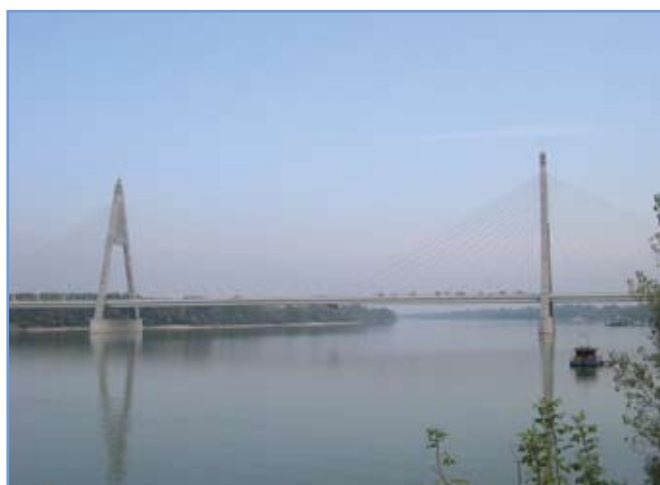
11. ábra: A kész kábelhíd a látogatóközpontból
