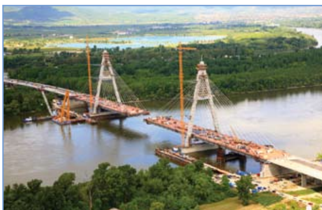
6. ábra: Konzolos szabadszerelés
