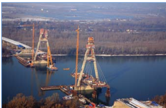
5. ábra: Épül a felszerkezet
