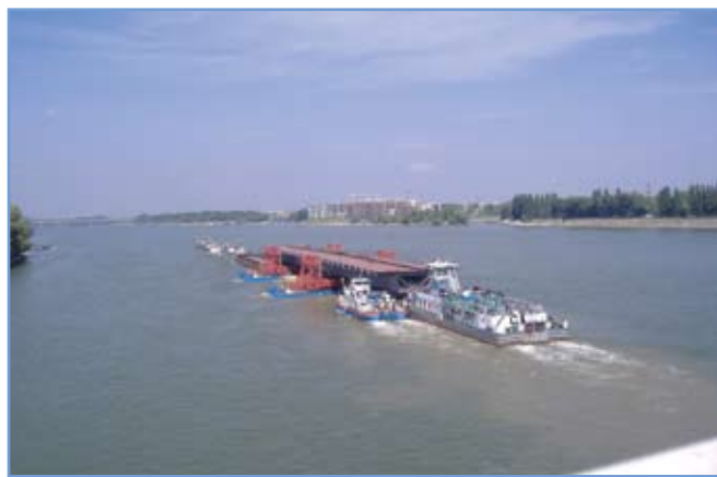
2. ábra: Hídelemek vízi szállítása
