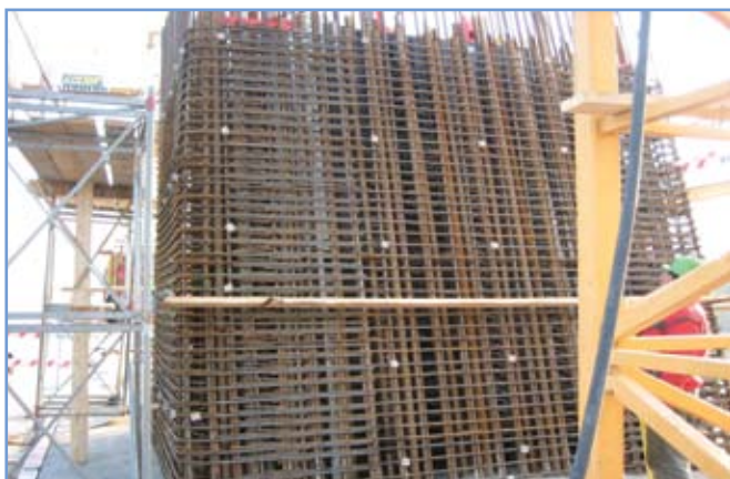
8. ábra: Pilon vasszerelés
