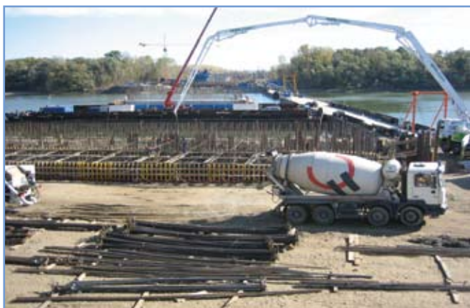
3. ábra: Talpgerenda betonozása
