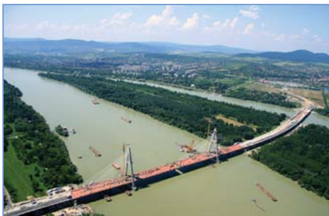
12. ábra: A felszerkezet a zárótag beemelése előtt
