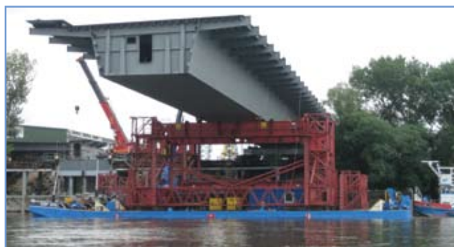
4. ábra: A Szentendrei Duna-ág híd egységének vízre tétele Csepelen
