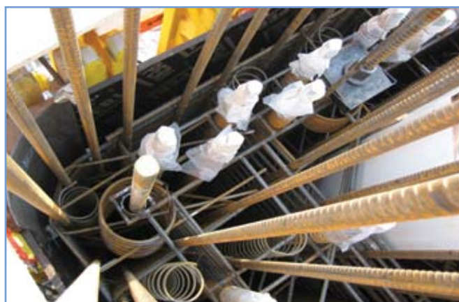
5. ábra: Pilon feszítőszerelvényei
