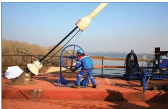
7. ábra: A feszítópázmák befűzése
