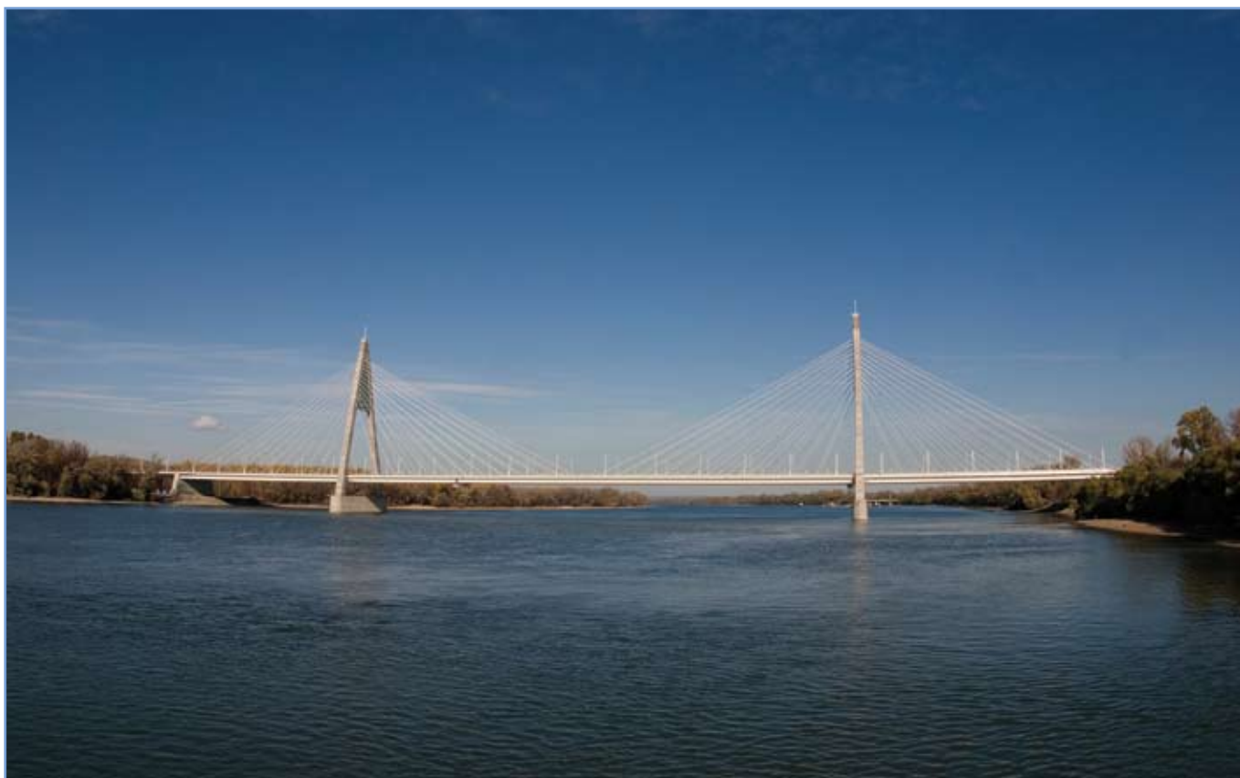
A megvalósult kábelhíd (fotó: Nyíró György)
