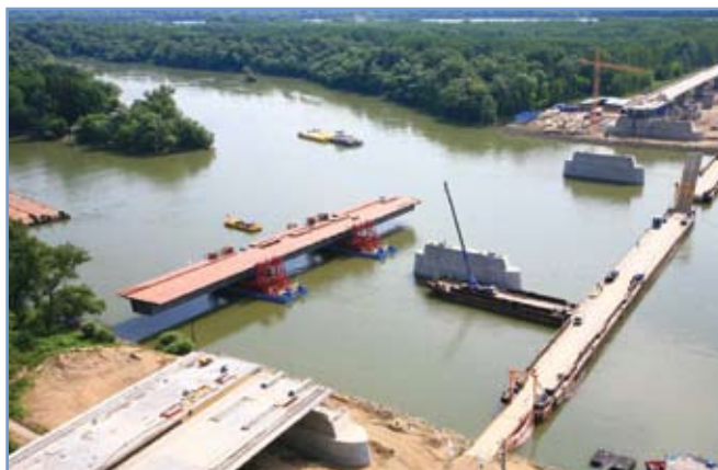
3. ábra: Hídtelep beúsztatása
