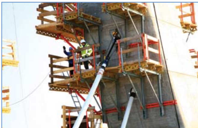
8. ábra: A tartókábelek bevezetése
