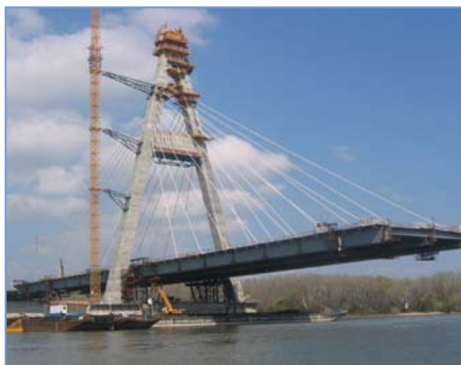
1. ábra: A pilon és a merevítőtartó egyidejű építése
