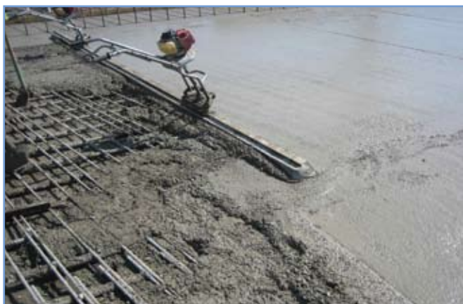
4. ábra: Pályalemez betonozása
