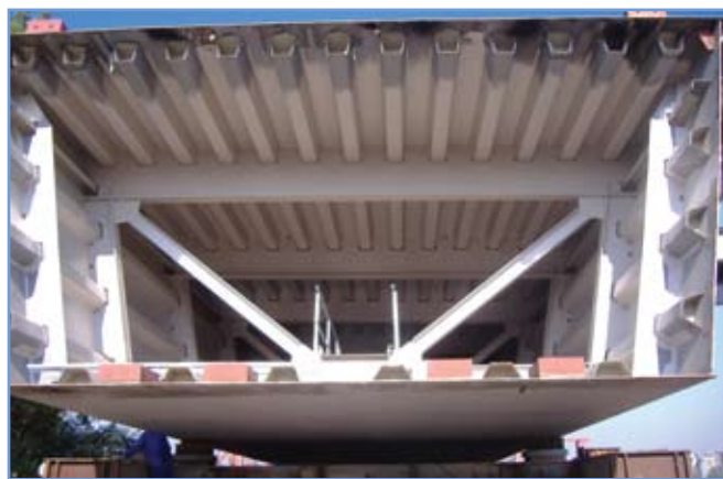
1. ábra: Korrózió elleni bevonat ellenőrzése
