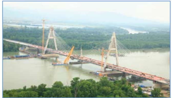
2. ábra: A pályaszerkezeti záróelem beemelése
