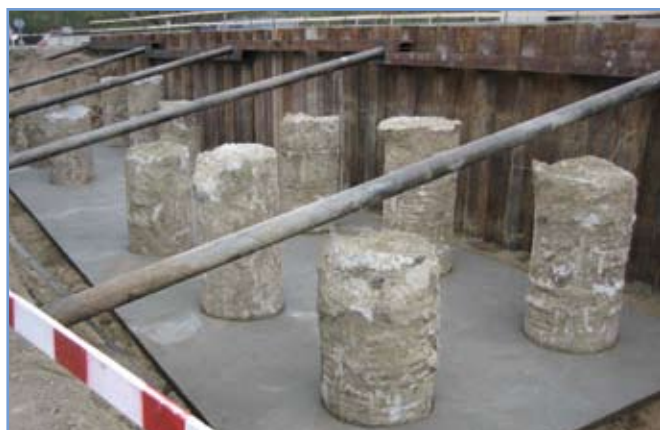
1. ábra: Levésendő cölöpök
