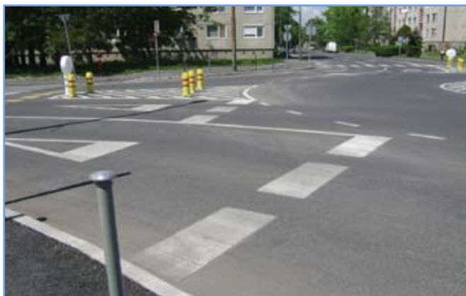
7. ábra: A belépő irányok eltolt kialakítása növeli a kapacitást
