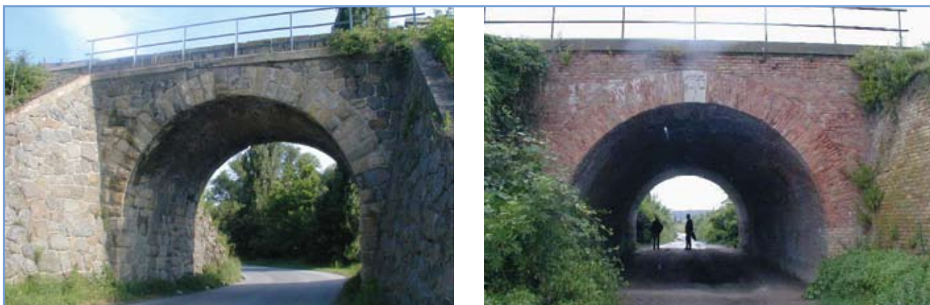
1. ábra: Tipikus kő- és téglaboltozatú hidak a MÁV vonalain
