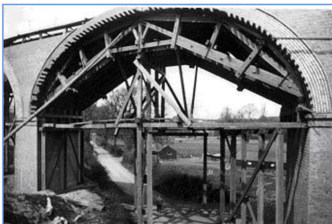
7. ábra: Boltozatok falazása mintaállványon (Forrás: British Waterways)
