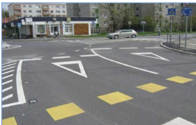
6. ábra: Az egyenes-balos és a jobbra kanyarodó forgalmi irány belépési pontjának részlete az egyirányú kerékpárút átvezetésével
