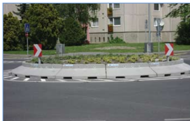
3. ábra: Az előregyártott vasbeton elemekből kialakított középsziget növényzettel beültetve
