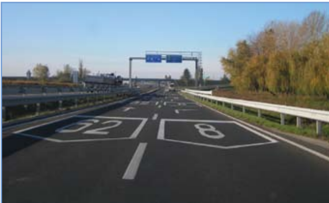
9. ábra: Útburkolati jelek és felfestések
