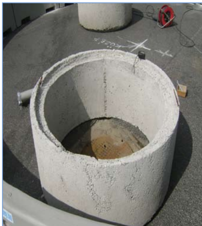
2. ábra: Az előre-gyártott elemek által körbevett területen belüli csatorna akna megmagasítása kútgyűrűvel
