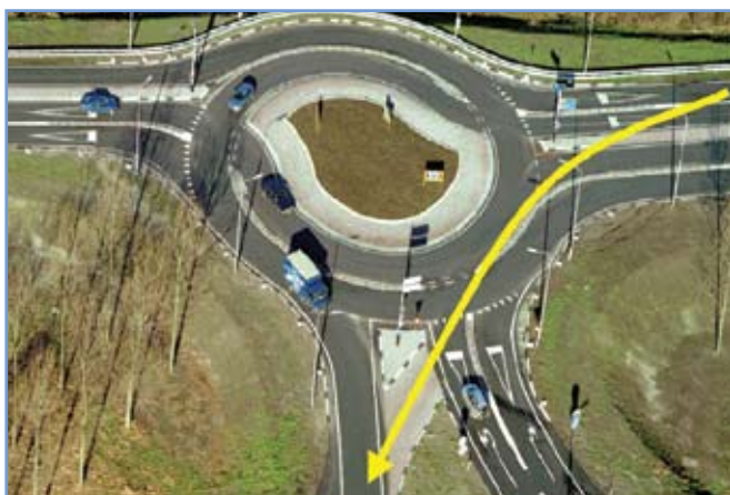
1. ábra – Csomópont „turbó kör” kialakítással
