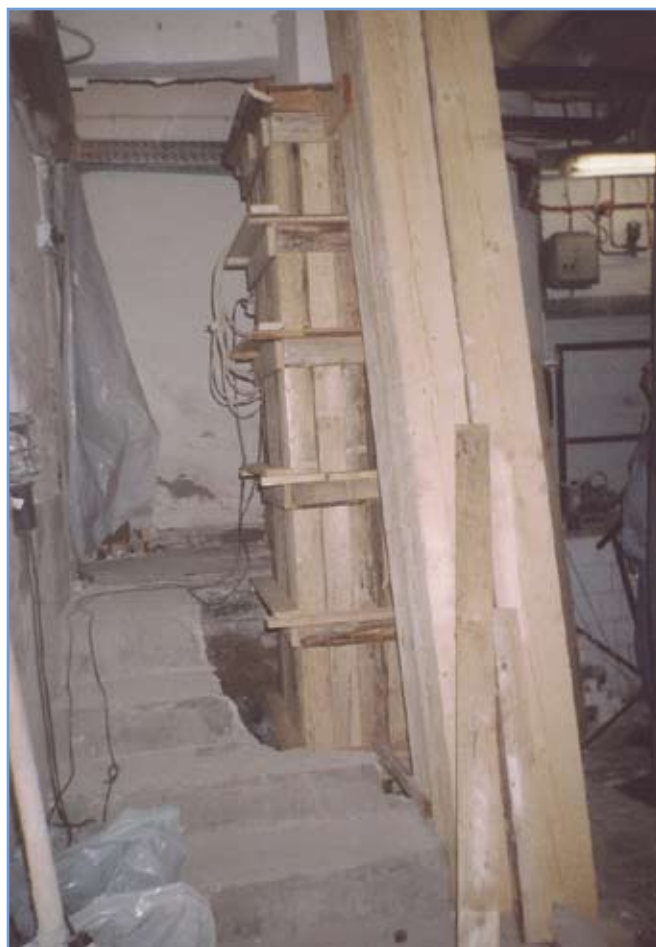
7. ábra: A bezsaluzott pillér és a biztosító dúcolat
