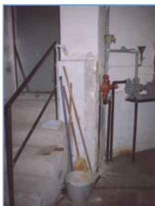
2. ábra: Károsodott pillér oldalról
