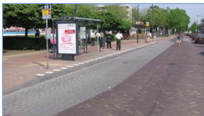
13. ábra - Az autóbusz megálló burkolata süllyesztve
