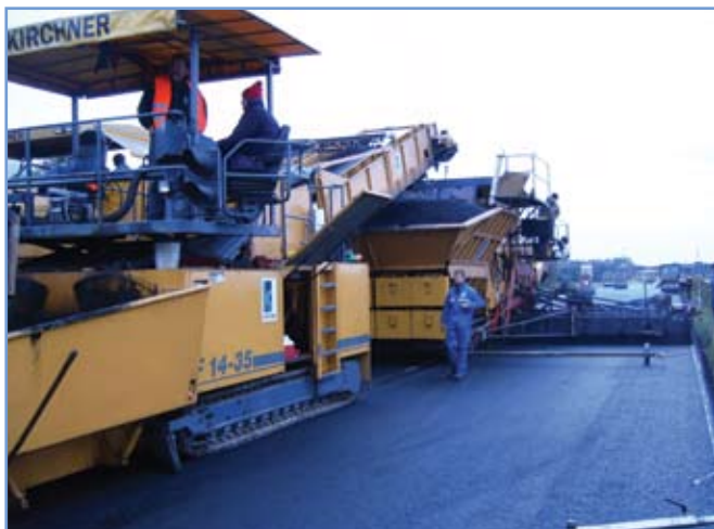
4. ábra. Kompaktaszfalt beépítése az A7 autópálya 9+500-11+000 km sz. Flensburg melletti szakasz
