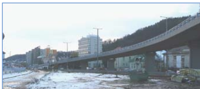
2. ábra: A Salgó utcai híd látványa a Hatvan felőli hídfő felé nézve
