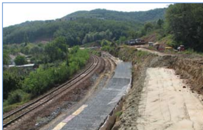
16. ábra: Gabionfal építése a vasúti pálya mellett
