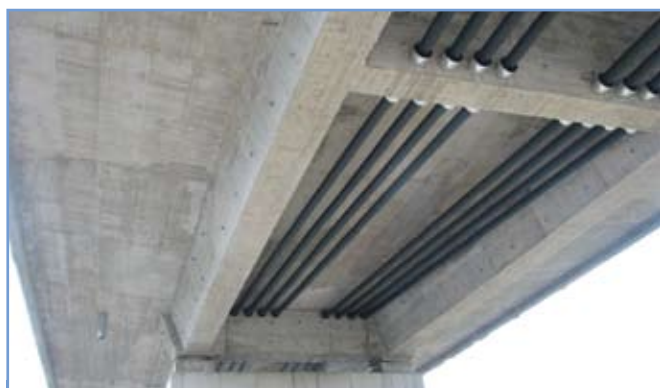
10. ábra: A híd alulnézete a feszítőkábelekkel és az iránytörőkkel
