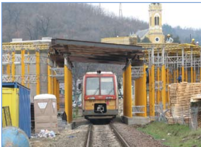
4. ábra: Állványozás a vasúti nyílásban
