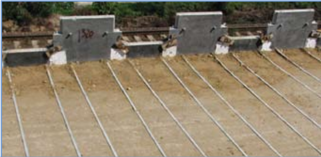
12. ábra: Építés közben kifektetett behorgonyzó acélzalagok
