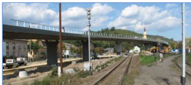
3. ábra: Az épülő híd látványa a vasútvonal felől nézve
