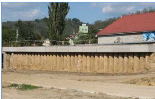
15. ábra: A vasúti pálya melletti cölöpfal építés közben
