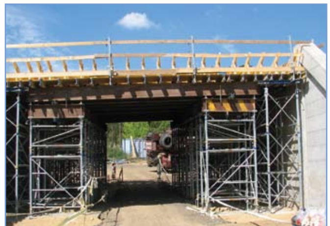
14. ábra: A Vadaskerti földút feletti híd beállványozott felszerkezete
