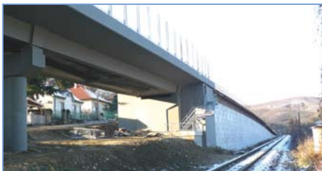
8. ábra: A vasalt talajtámfalak kialakítása
