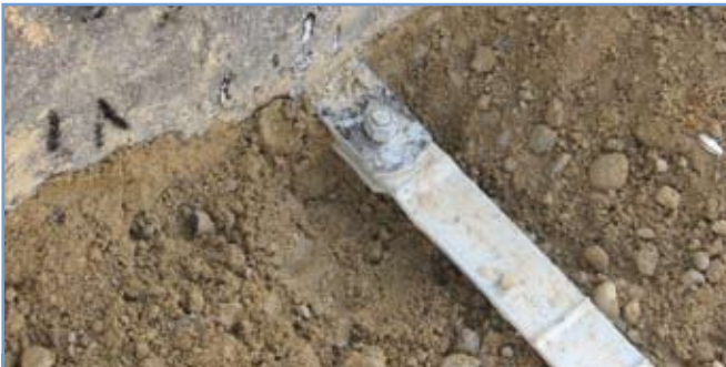
13. ábra: Behorgonyzó acélzalag bekötése a homlokfalba
