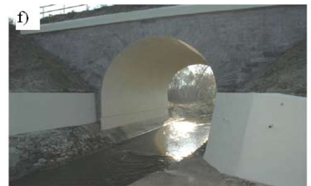
8. ábra: 7,00 m nyílású boltozott híd megerősítése teherelosztó lemezzel a) elemek beépítése, b) szigetelés, c) elemek feszítése, d) pályaszerkezet visszaépítése, e) felületvédelem, f) elkészült híd
