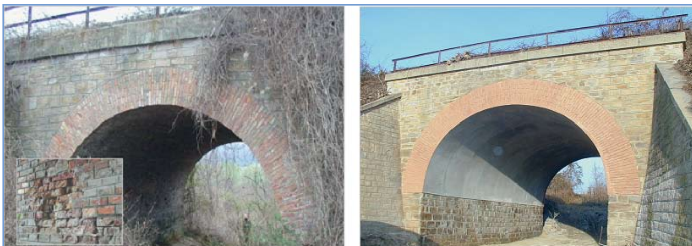
5. ábra: 5,70 m nyílású boltozott híd felújítása vékony löttbeton kéreggel és injektálással
