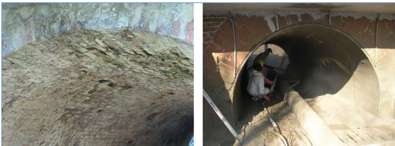
6. ábra: 2,00 m nyílású boltozott átérész felújítása vékony löttbeton kéreggel
