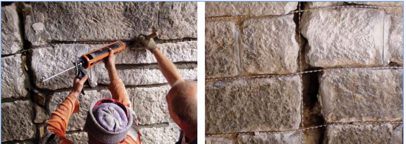
7. ábra: Kőboltozatú híd repedéseinek áthidalása rozsdamentes spirálacéllal
