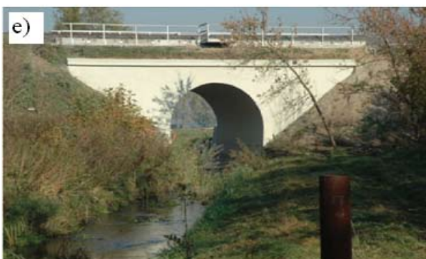
8. ábra: 7,00 m nyílású boltozott híd megerősítése teherelosztó lemezzel a) elemek beépítése, b) szigetelés, c) elemek feszítése, d) pályaszerkezet visszaépítése, e) felületvédelem, f) elkészült híd
