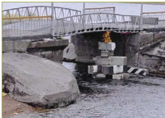
5. ábra: A teljes élettartam gazdasági vége: bár az áthaladás lehetséges, a szerkezet kívánatos szolgáltatási, ill. kockázati szintje gazdaságosan nem állítható helyre
