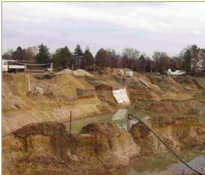
1. ábra: Siemens – kutakkal sem lehetett lesüllyeszteni a talajvíz-szintet.
