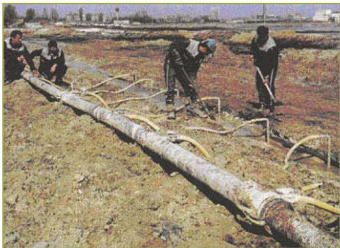
6. ábra: Kavicsrost feltöltése bentonitos szuszpenzióval.
