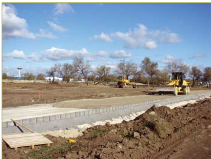
3. ábra: Ipari út alapréteg építése
