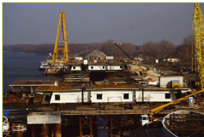
14. ábra: A mederhíd szerkezetének szerelése a parton
