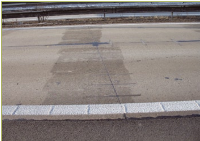
3. ábra: Marás, teherátadó acélbetétek és kötővasak utólagos behelyezése a D11-es autópályán (133 km, Prága irányában).
