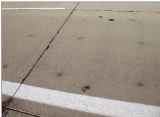
4. ábra: Táblaemelés a D1-es autópályán, a Prága felé vezető pályán, a 119,5 km szelvényben, a haladó sávban
