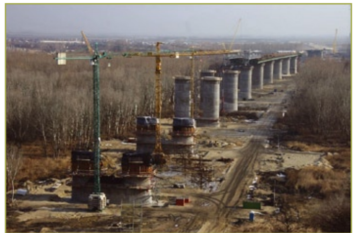
11. ábra: Az épülő híd látképe a jobbparttól nézve
