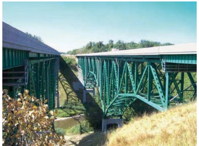
1. ábra: A Grand River híd az I-90 autópályán (Ohio állam, USA)
