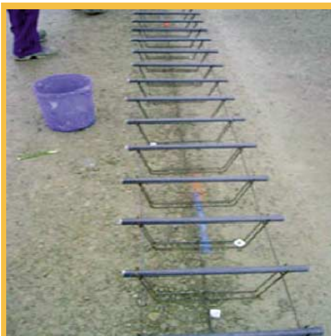
13. ábra: Előre elhelyezett hézagvasalás
