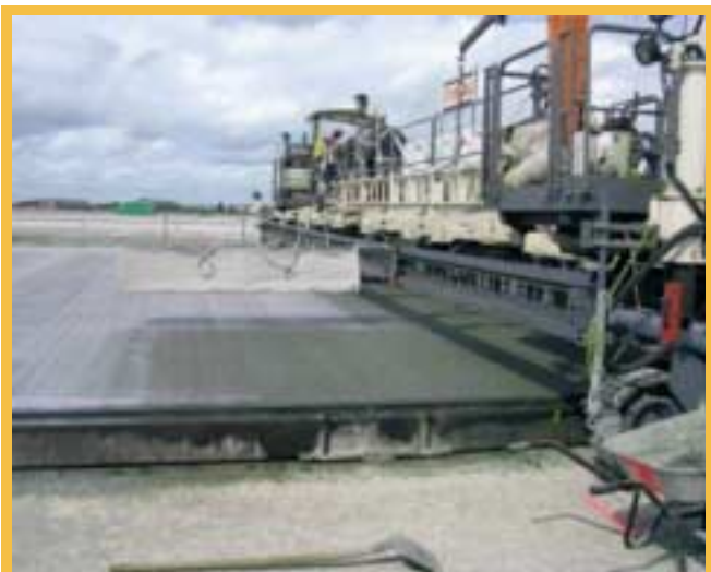
11. ábra: Az utókezelő párazáró anyag felhordása
