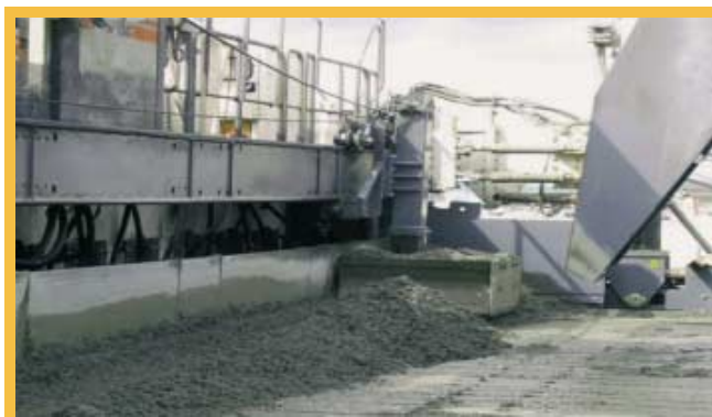
5. ábra: A felsőbeton anyagát elosztó géplapát
