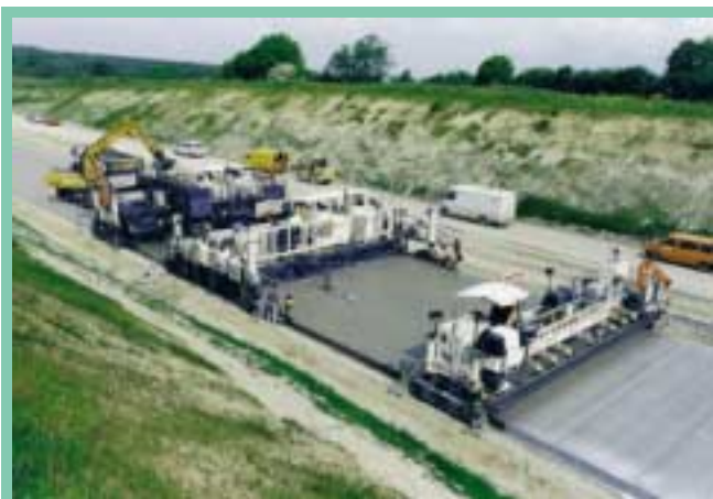
3. ábra: A Wirtgen SL-1500-as betonburkolat építő géplánc
