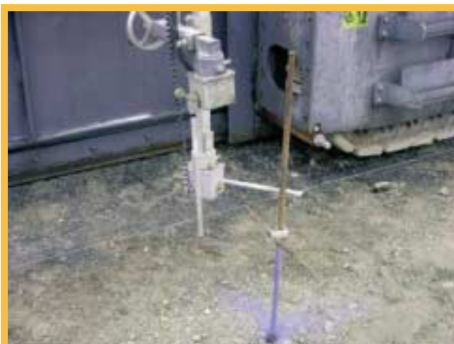
1. ábra: A pálya vízszintes és magassági vonalvezetését a burkolatépítőgép számára rögzítő referencia huzal
