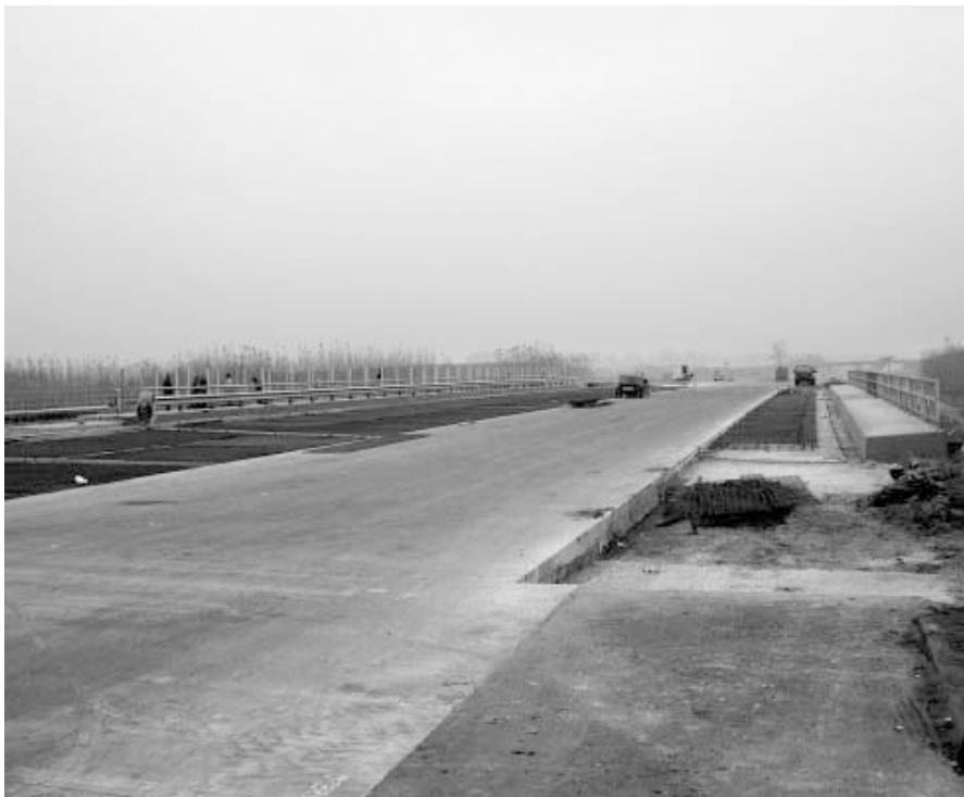
13. ábra: Félig kész betonburkolat a 330 j. hídon
