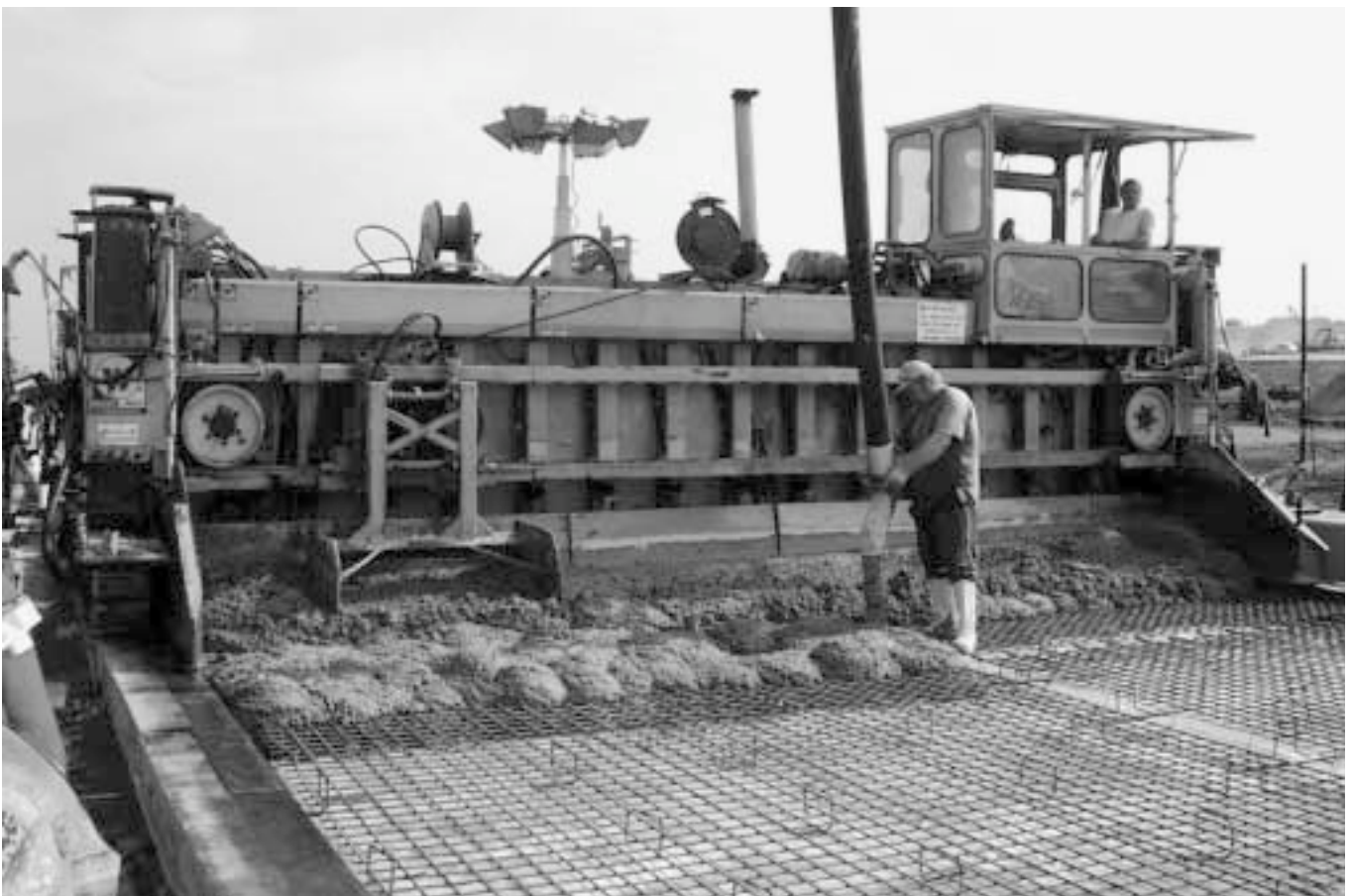
12. ábra: Betonburkolat építése a 307/B j. hídon
