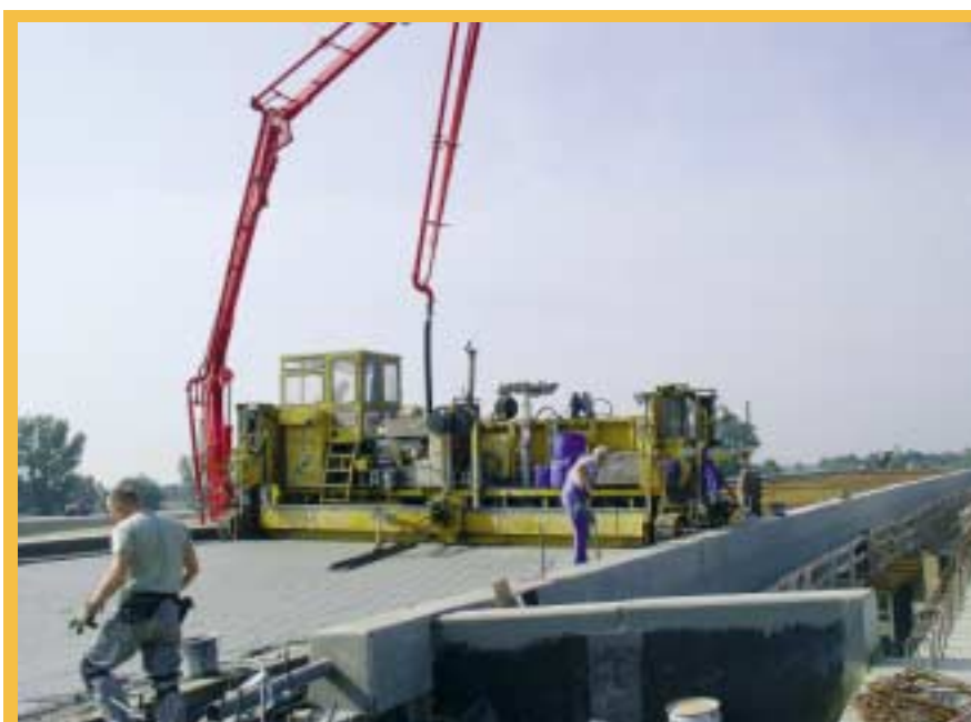
1. ábra: A Walter Heilit VWB finiser munka közben egy csomóponti felüljáró betonburkolatának építésekor
