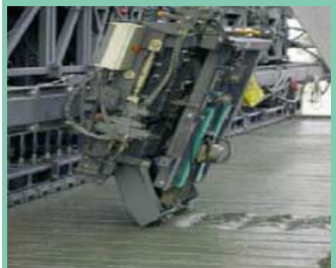
8. ábra: A hosszhézag horgonyvasakat elhelyező automata
