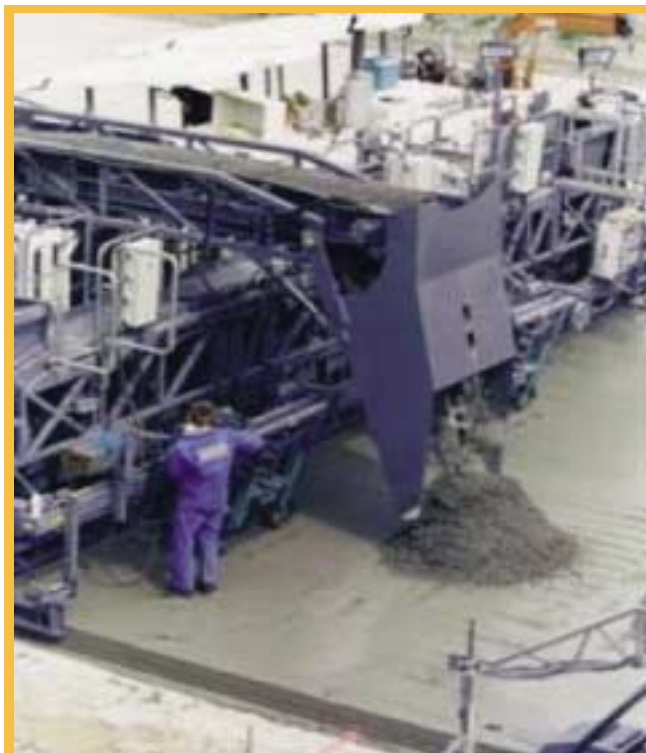
4. ábra: A felsőbeton anyagát adagoló segédgép
