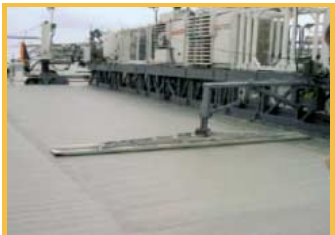
9. ábra: A második finiser felületképző simítótagja
