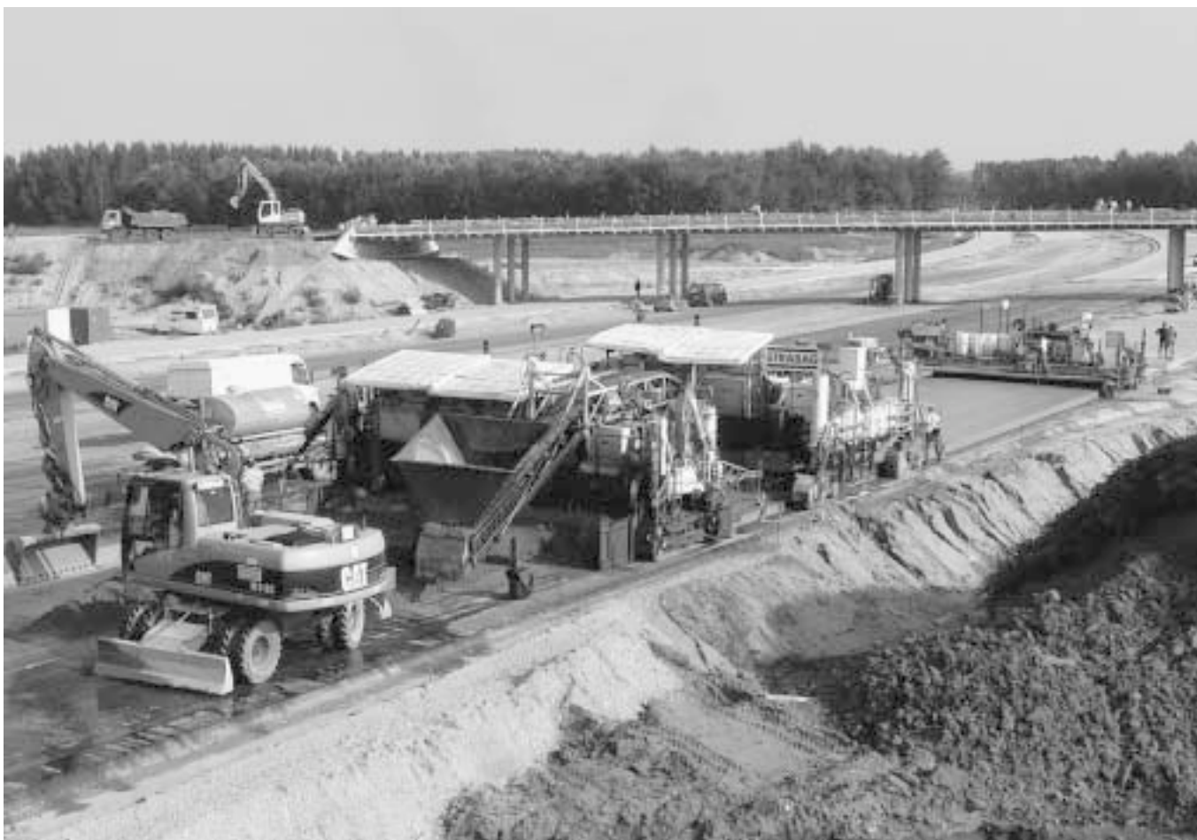
2. ábra: A Wirtgen SP 1500 L burkolatépítő géplánc az M0 autópályán munka közben
