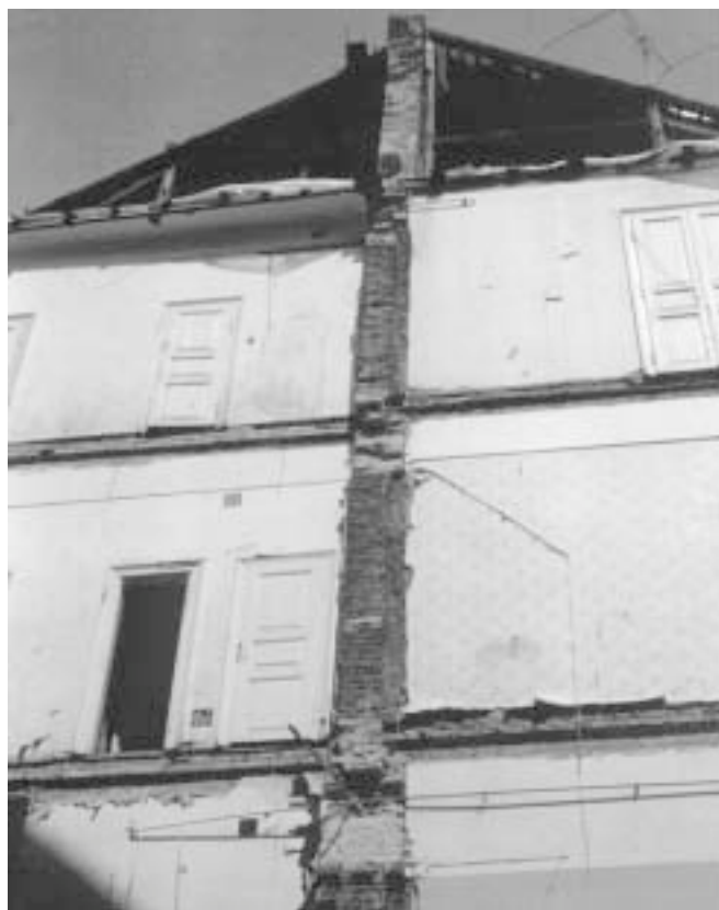
5. ábra: A középső főfal k-i csatlakozása az épen maradt szimmetrikus utcai épületrészhez
