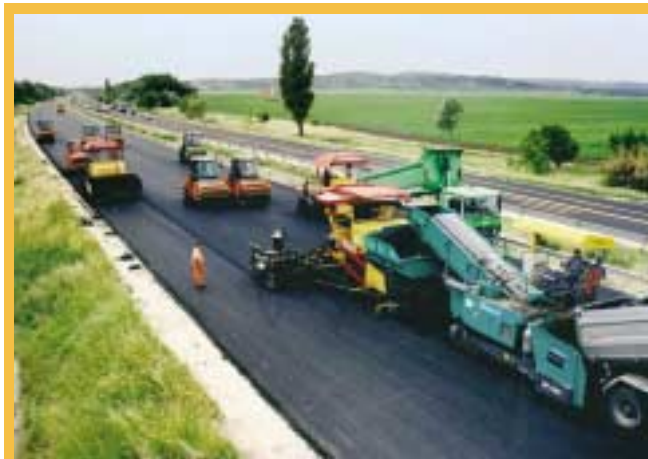
5. ábra: Aszfaltkompos kopóréteg építés az M7 rekonstrukción
