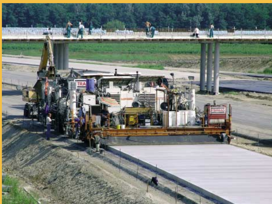
4. ábra: Betonburkolat építése az M0 keleti szektorában a 29–42 km szakaszon
