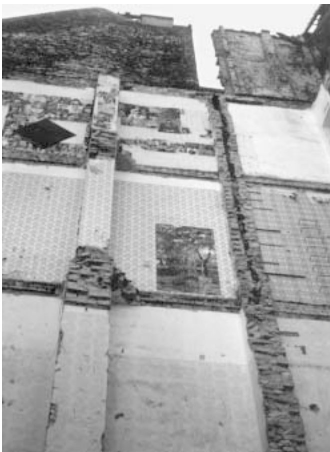
4. ábra: A középső főfal nyílással áttört ny-i vége a földém bekötésekkel
