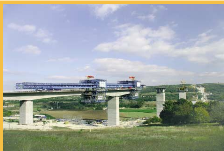
9. ábra: Az M7 kőröshegyi völgyhídjának építési állapota 2005 őszén
