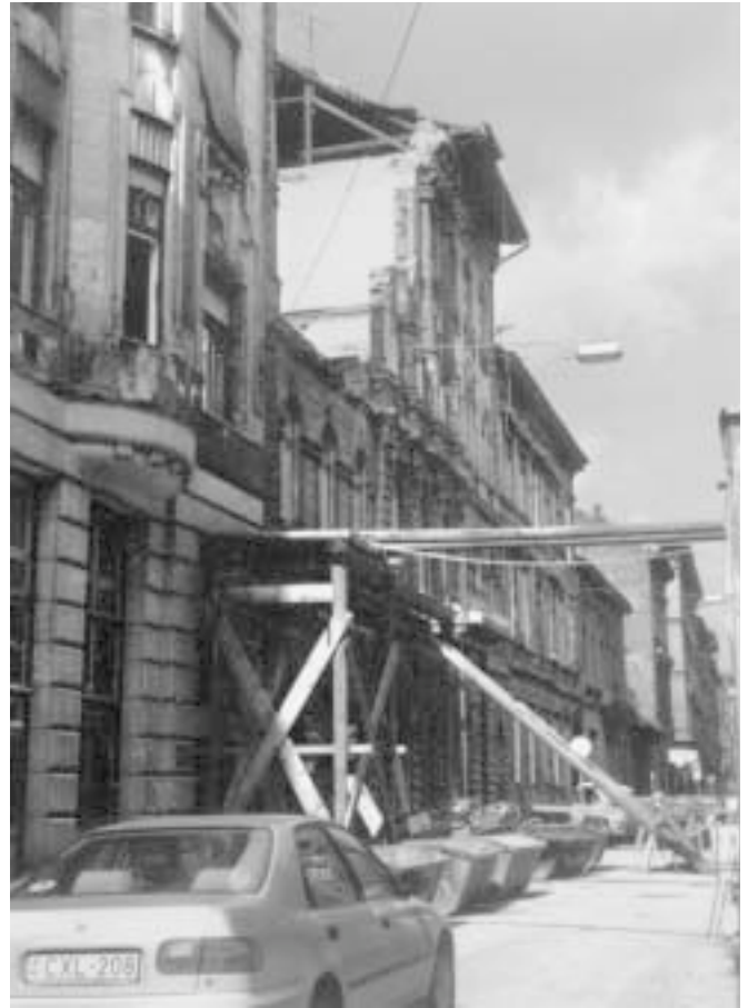
2. ábra: Felvétel a d-i utcai homlokzatról a tönkremenetel utáni bontásról és a megtámasztásról
