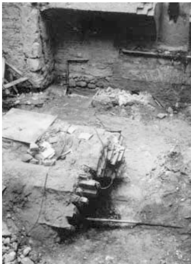
6. ábra: A pince kimélyítése, az alapok szerkezete és a boltozat kompakt tömbje a romok eltakarítása után
