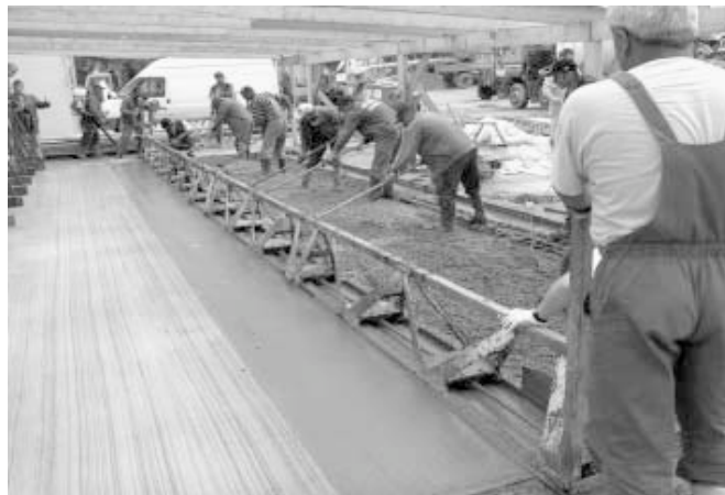
2. ábra: Felületképzés TREMIX SVE típusú vibrációs lehúzógerendával
