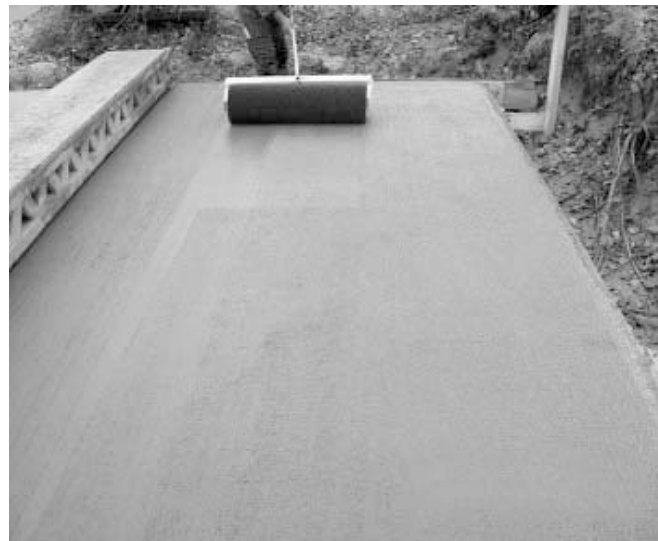
4. ábra: A beton felületének érdesítése műfüves hengerrel
