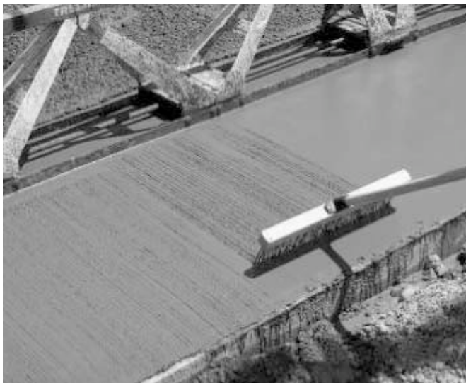
3. ábra: A beton felületének érdesítése seprűvel
