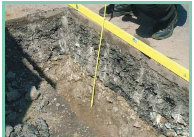
6. ábra: 35. sz. út. Burkolatfeltárás
