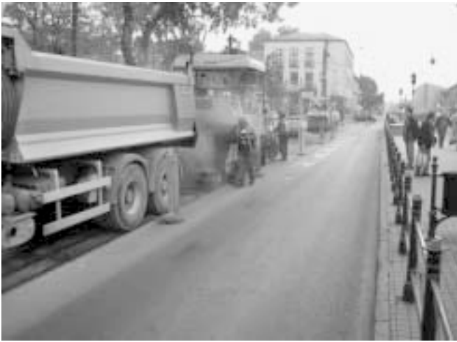
17. ábra: A keverék beépítése
