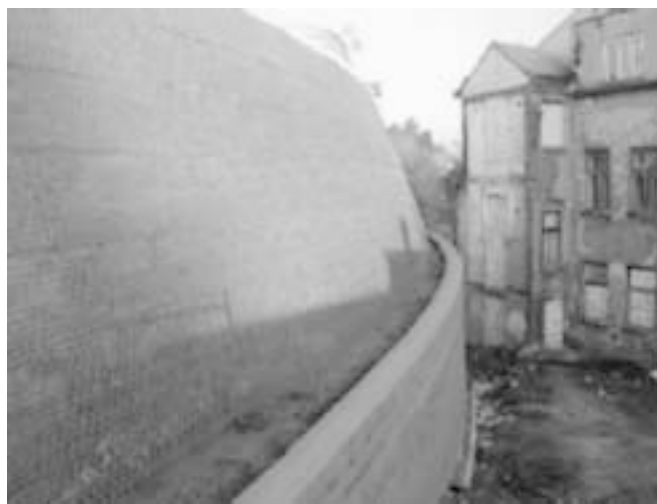
12. ábra: Az építmény felső része acélháló és kókuszgyékény burkolattal
