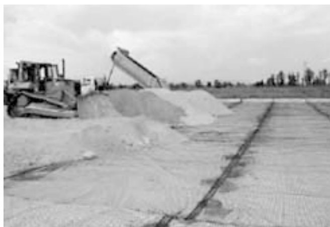
5. ábra: Az M7 autópálya. Töltésalapozás Armatex G 35/35 georáccsal
