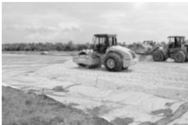
6. ábra: Szemcsés töltésalapozó réteg tömörítése Armatex G 35/35 georácson
