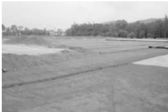
8. ábra: Karlovy Vary, Interspar. Töltésanyag terítése az Armatex georácsra
