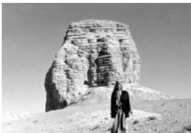
1. ábra: A gyékény szőnyeggel megerősített vályogtéglából épített zikkurat (lépcsős templom) romjai Akar Kufban
