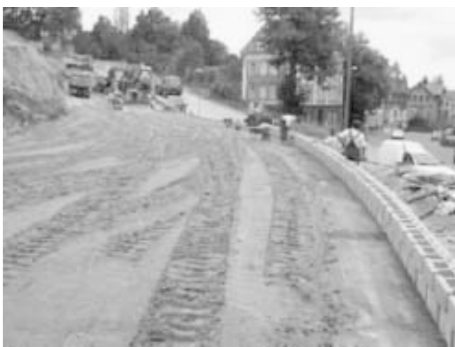
10. ábra: Üreges beton-blokkok elhelyezése Armatex erősítő elemekkel
