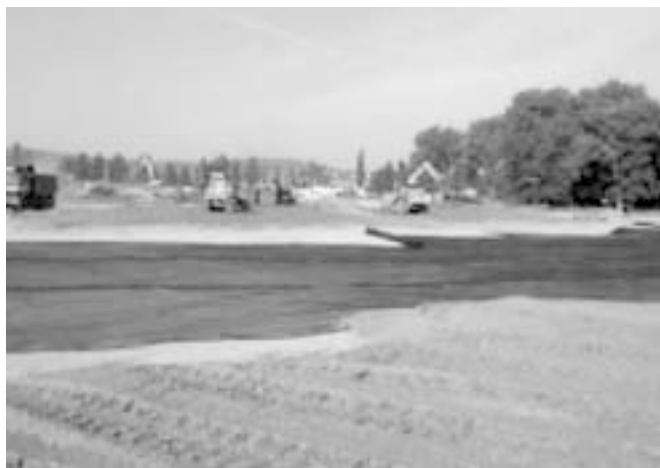
7. ábra: Karlovy Vary, Interspar bevásárlóközpont. Az Armatex georács fektetése
