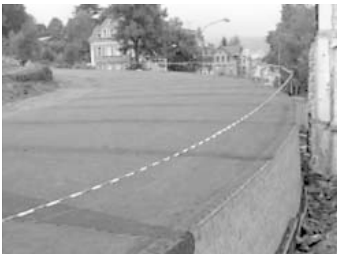
11. ábra: Erősített talajszerkezet épül egy háztól egy méterre
