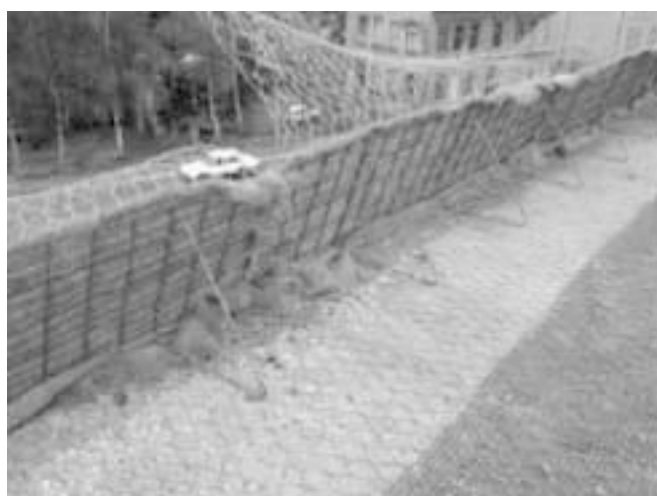
13. ábra: Az acélháló burkolat belső oldala, melyet Armatex georács átfed
