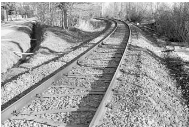
6. ábra: Az Y-aljas vágány kialakítása és környezete az 1041+40 szelvényben
