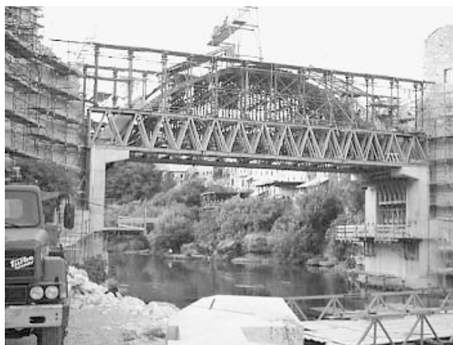
13. kép: A beton lábazat és az állvány a boltívvél
