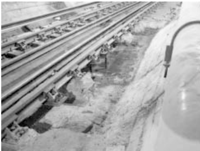
4. ábra: A megrongált pályaszakasz újrabetonozása
