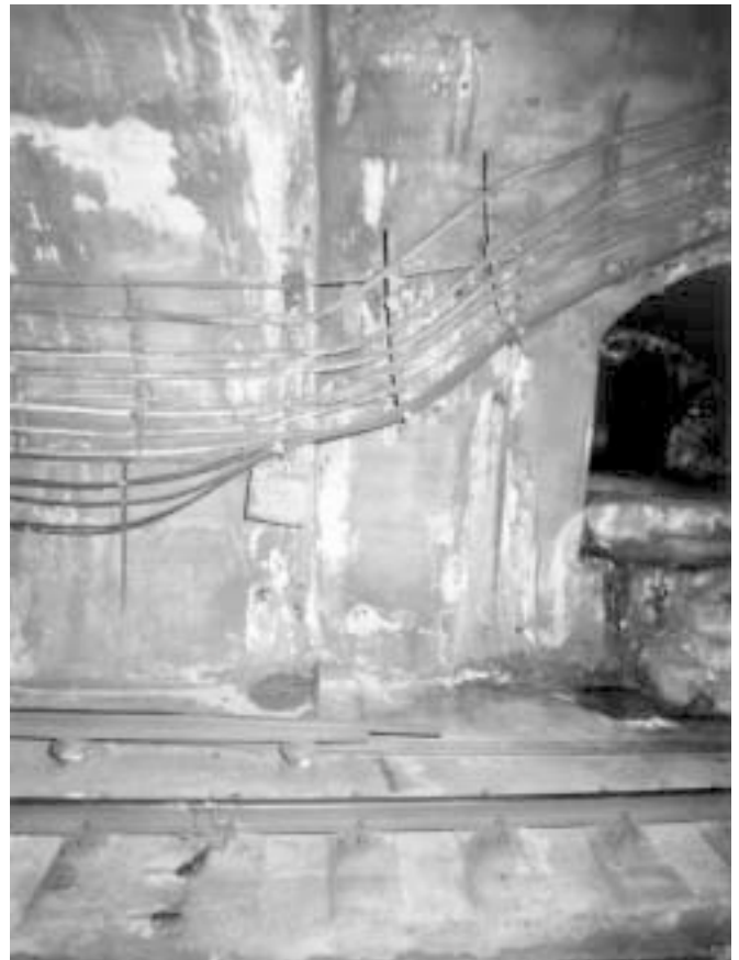
3. ábra: Torkkrét szigetelésű monolit beton alagút (Fotó: Tóth Gyula)
