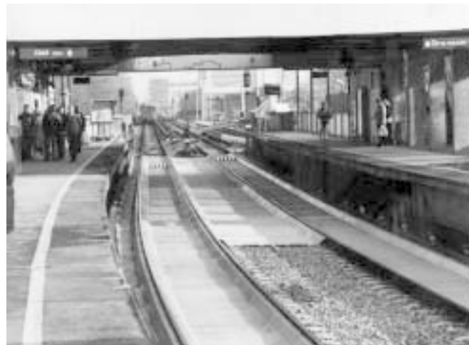
5. ábra: Vágányburkoló tálcák a Pillangó utcai állomáson
