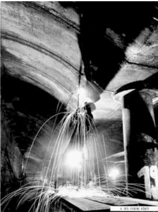
2. ábra: Acéllemezzel szigetelt metróállomás (Fotó: Tóth Gyula)
