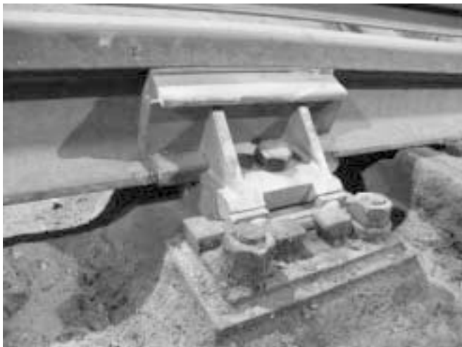
5. ábra: Ortec Deltalager MII. leeresztés
