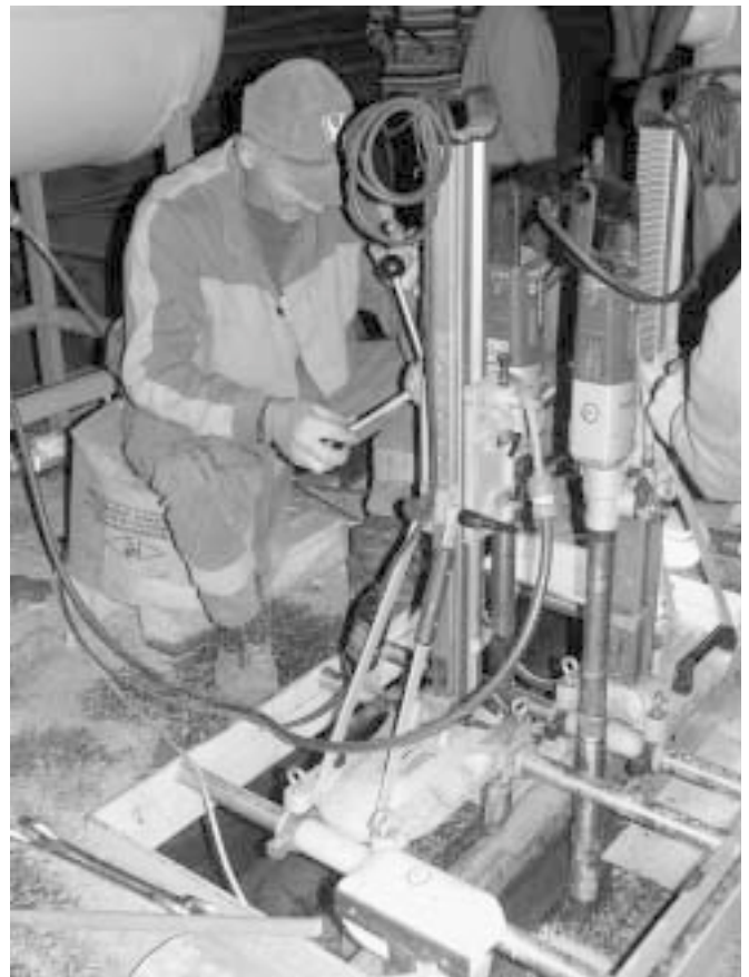
1. ábra: Sínen mozgó fúrókocsi, működés közben
