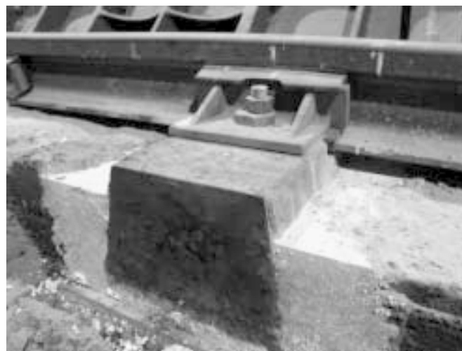
3. ábra: Ortec Deltalager M1. leerősítés
