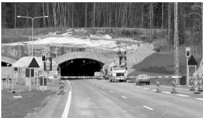
1. ábra: Forgalomtechnikai berendezések az Isokylä alagút bejáratánál
