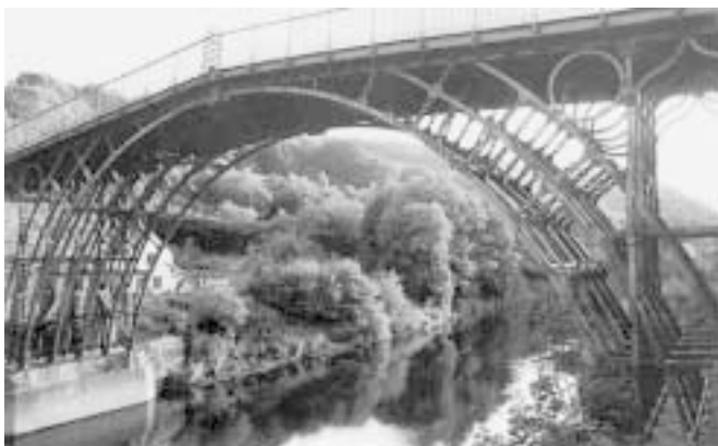
1. kép: Az Iron Bridge a Severn folyó fölött (1779, támaszköz: 30,5 m)
