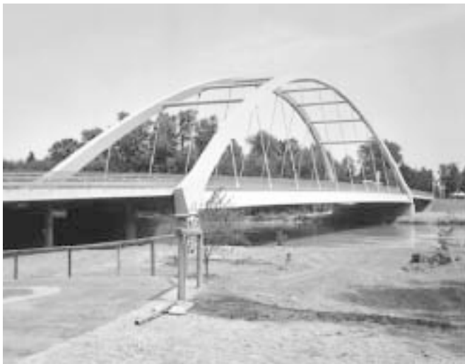
14. ábra: A neubeuerni Inn-híd
