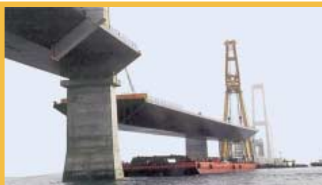
27. kép: A szélső híd utolsó nyílásának beemelése (súlya 2400 t, hossza 193 m)
