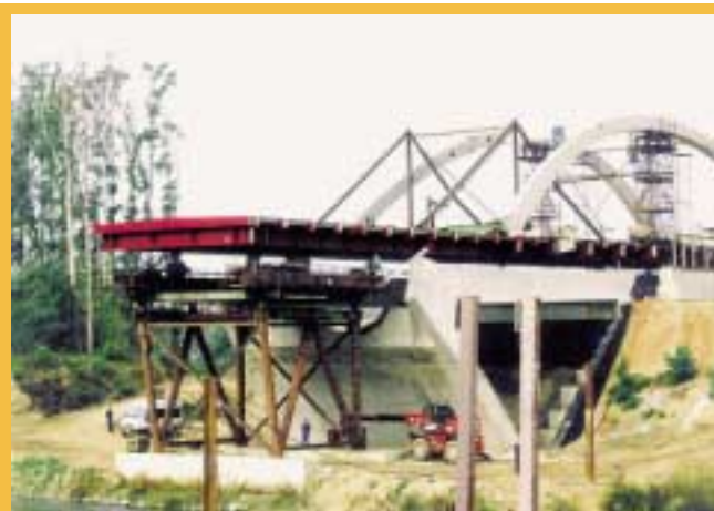
3. ábra: a felszerkezet építése
