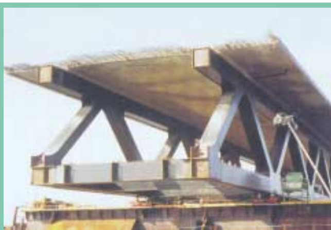
29. kép: A híd keresztmetszeti elrendezése
