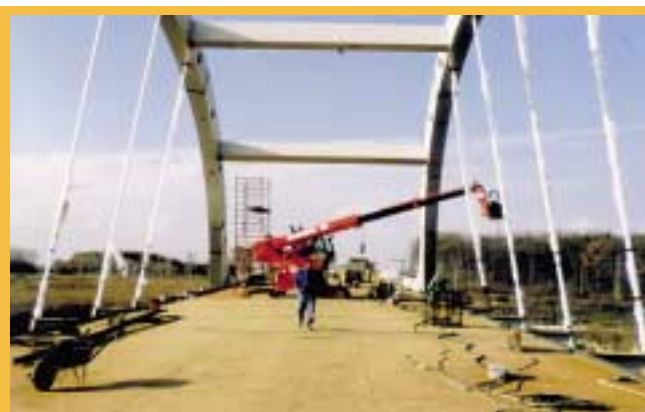
4. ábra: a tartókábelek beépítése
