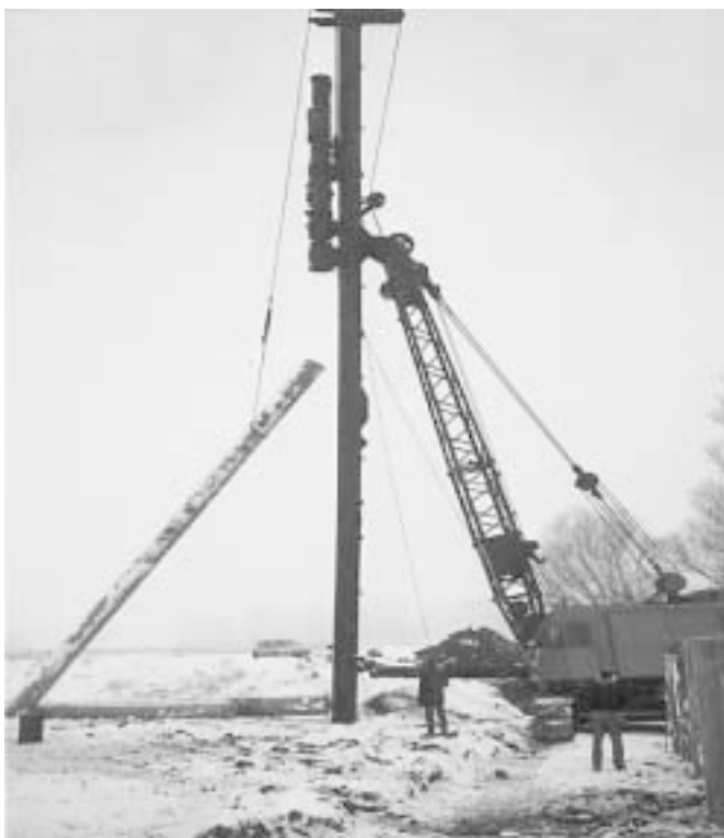
5. ábra: DELMAG32 cölöpöző gép
