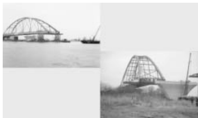
13. ábra: A tangermündei Elba-híd, a szerkezet beúsztatása
