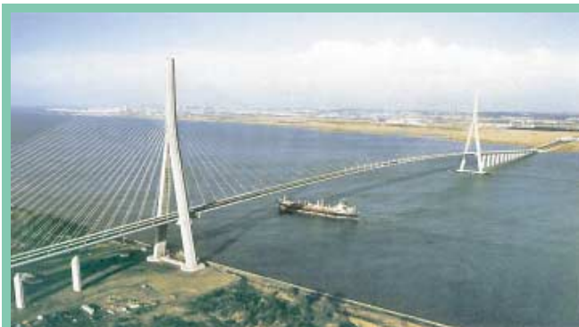
23. kép: A franciaországi ferdekábeles világrekorder Normandie híd (1995)
