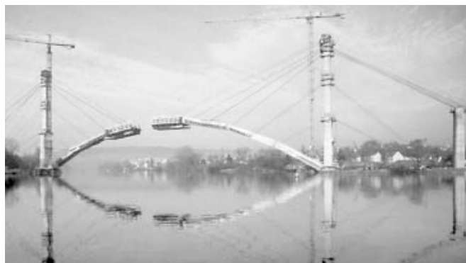
3. ábra: Vasúti híd Veitshöchheimnél, az ív szerelése
