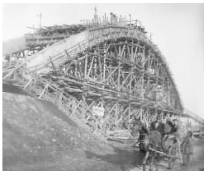
2. ábra: A híd építése (Dr. Träger Herbert felvétele, 1953.)
