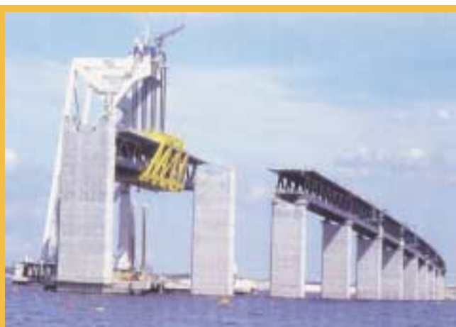
30. kép: Egy szélső nyílás beemelése
