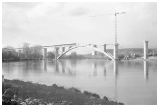
4. ábra: Vasúti híd Veitshöchheimnél, a pályaszerkezet betolása
