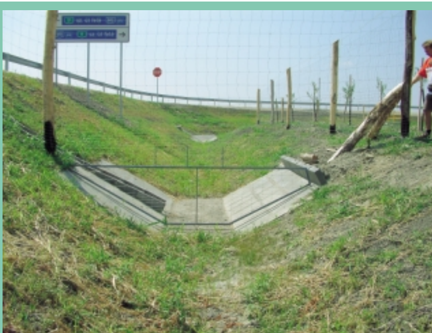
3. ábra: Védőkerítés átvezetése árok felett
