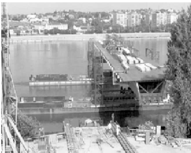
3. ábra: Úsztatási előkészületek a csepeli szerelőtéren
