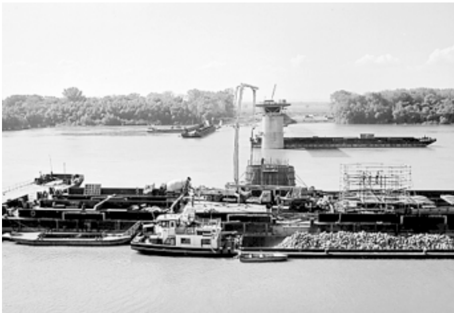
5. ábra: A hídpillér építése
