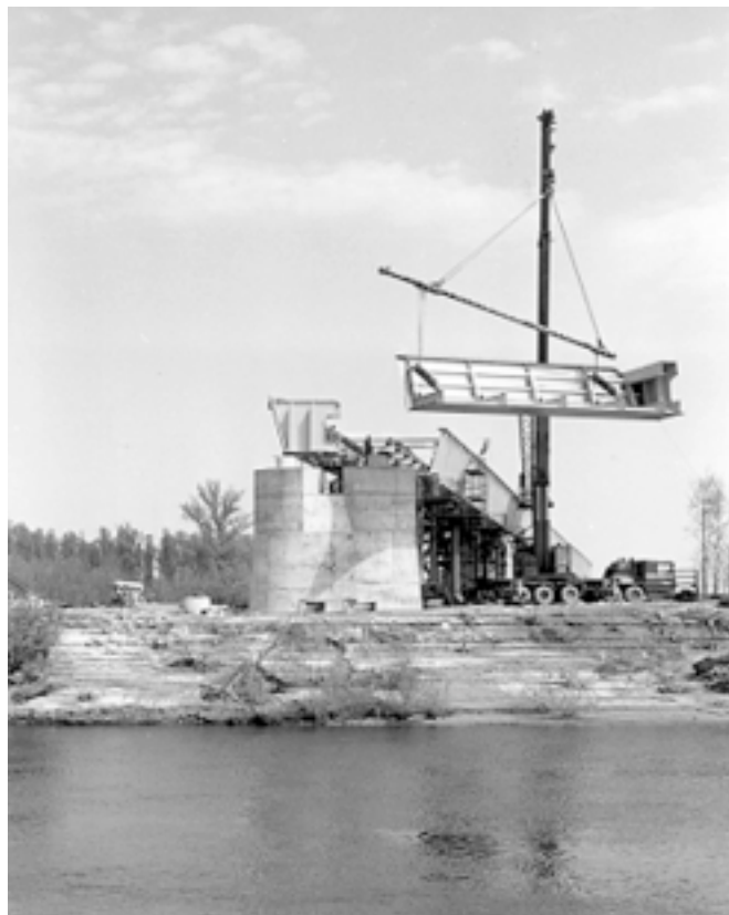
1. ábra: Az ártéri híd szerelése
