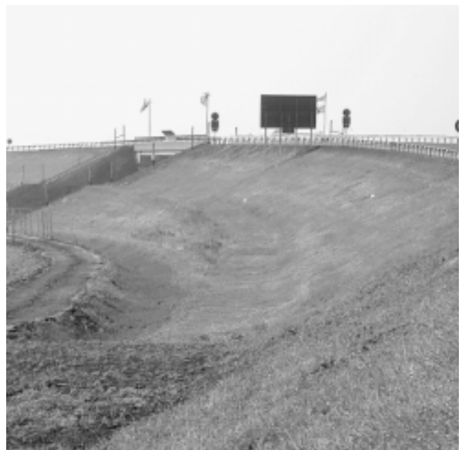
1. ábra: Kezelőpadka az autótút magas töltésű szakaszán
