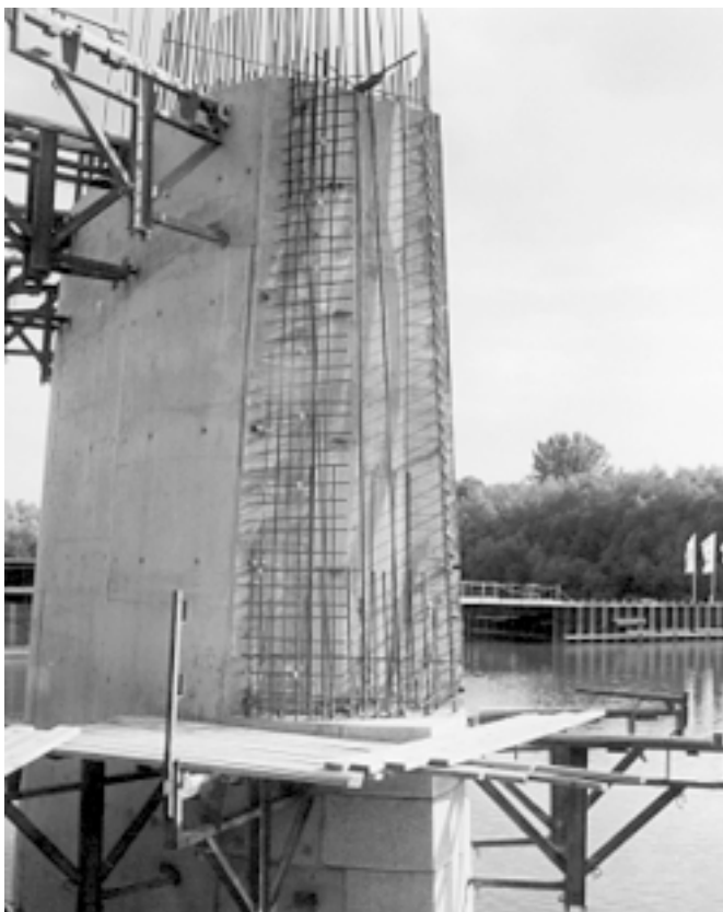
6. ábra: A hídpillér gránitkő burkolása
