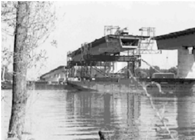
4. ábra: A hídelemek elhelyezése
