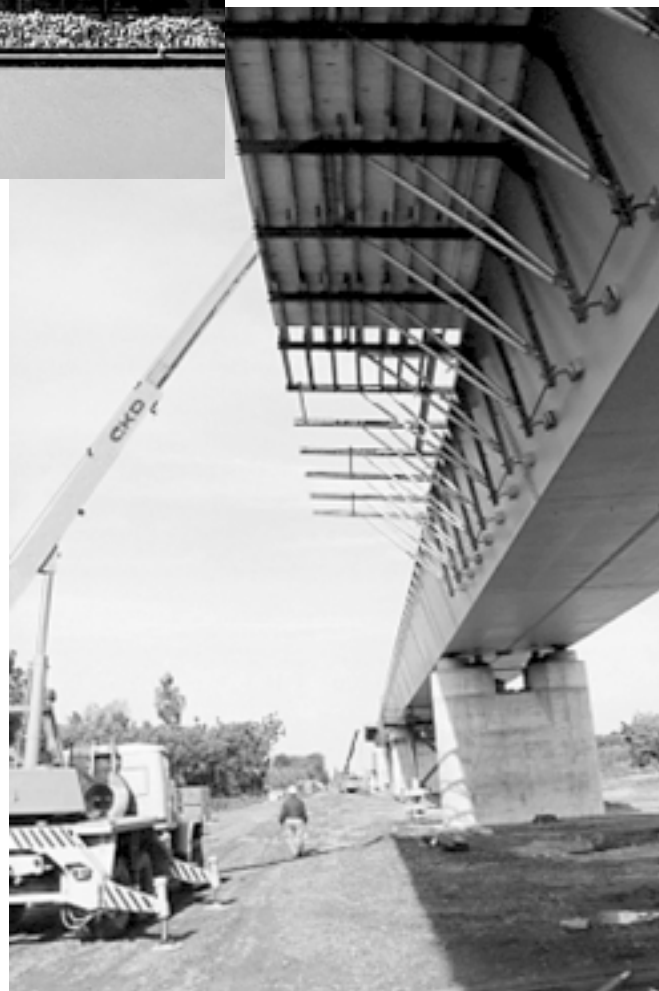
7. ábra: Az ártéri híd felszerkezet építése
