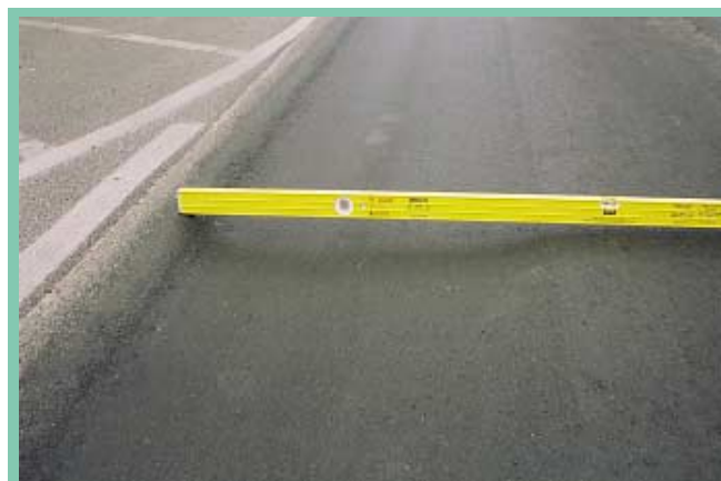
1. ábra: Keréknyomvályúk jelzik, hogy a hagyományos aszfaltkeverékek teljesítménye kimerült
