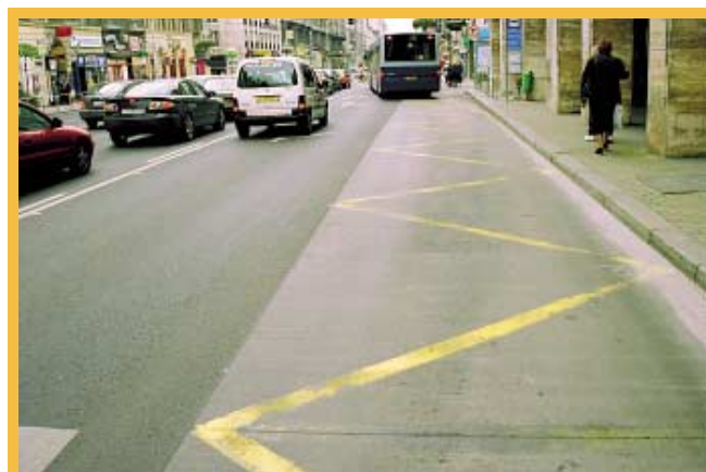
2. ábra: Az autóbusz megálló burkolatánál a beton burkolat nyújtja a tartós megoldást
