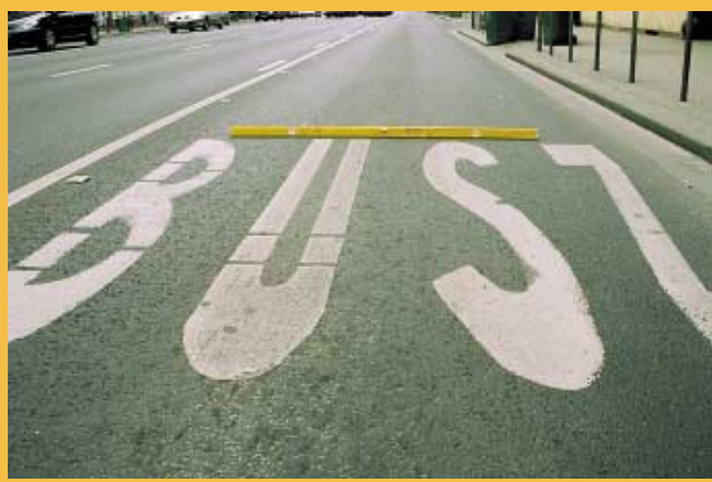
4. ábra: Nincs keréknyomvályú 3,5 évi állandó terhelés után sem
